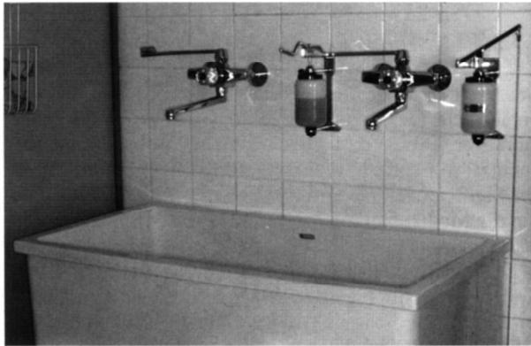
*Abbildung 1: Waschvorrichtung mit Armaturen zur Ellenbogenbedienung, Seifen- und Desinfektionsmittelspendern (BRÜSE 2001a)*
