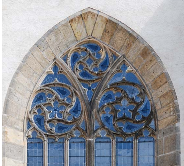
Bild III.26: Bautzen, St. Peter, südliches Seitenschiff, Vier- und fünfzählige Rotationsfiguren aus Fischblasen, (1456-1463).
