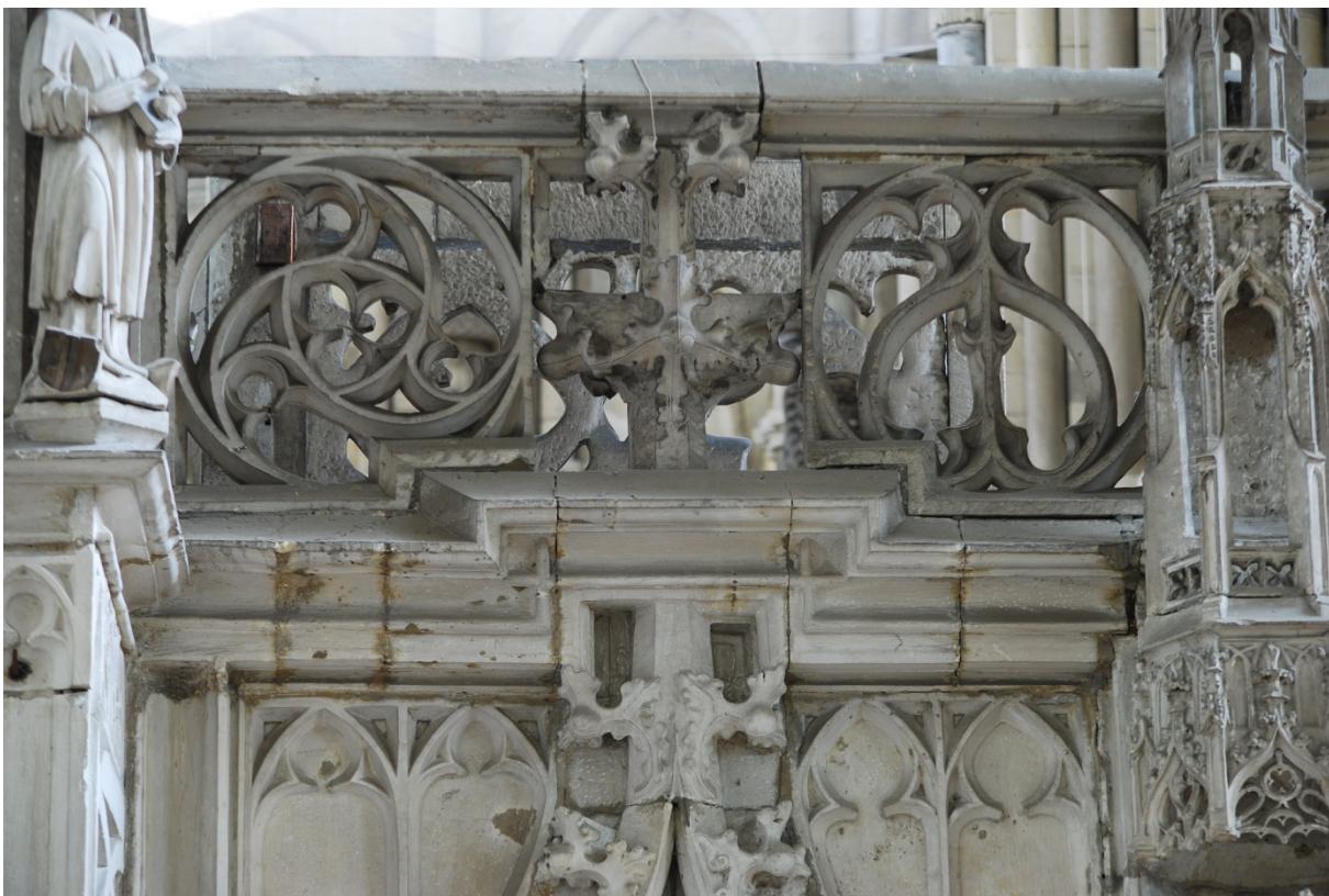
Bild III.17: Maßwerk der Brüstungsfelder We und Wf über dem südlichen Lettnerdurchgang.
