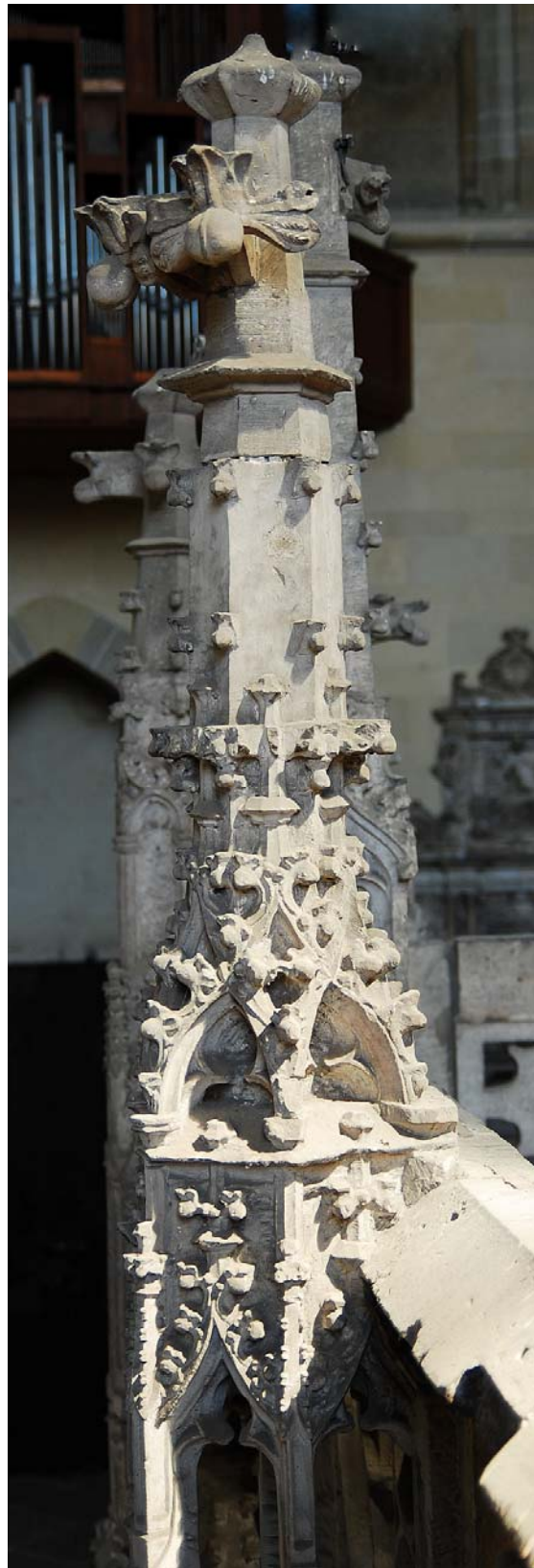
Bild III.5a: Baldachinturm über Mauritius. Übergangsegment in Kalottenform mit einander überschneidenden, sphärischen Kielbögen. Ansicht von Süden in Höhe der Lettnerbühne. Im offenen Turmsegment Lanzetten mit Vorhangbögen, die von geschweiften Wimpergen überfangen sind.
