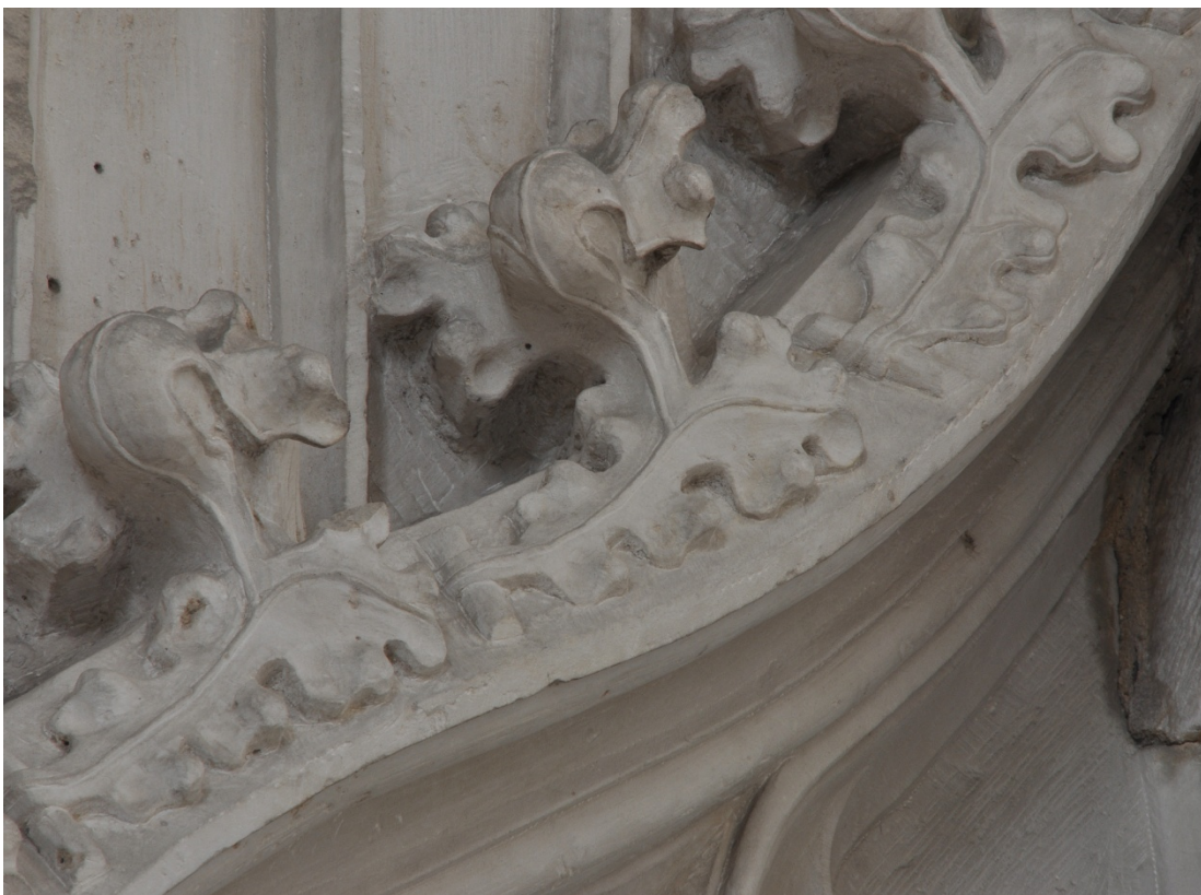
Bild II.11b: Krabben am Kielbogen Georg, nördlicher Schenkel. Die Krabbenformen auf den beiden Bogenschenkeln gehören zwei unterschiedlichen Zeitphasen an.
