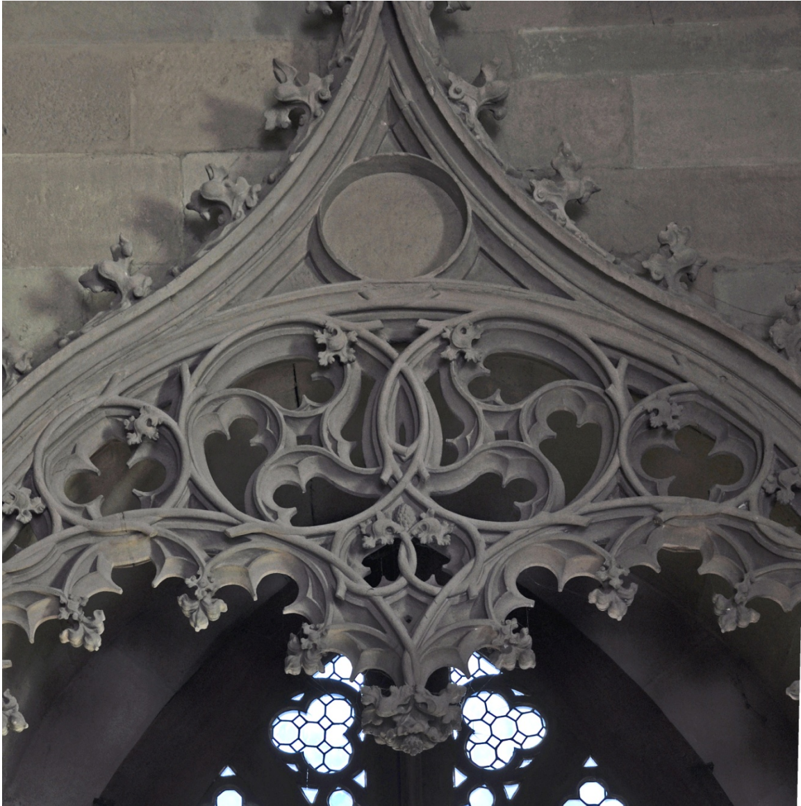
Bild III.25a: Mainz, Dom, Ansicht der Memorienpforte von Süden (Schauseite zur Memorie). Madern Gerthener: Hängendes Maßwerk mit Rotationsfiguren aus Fischblasen, um 1425.
