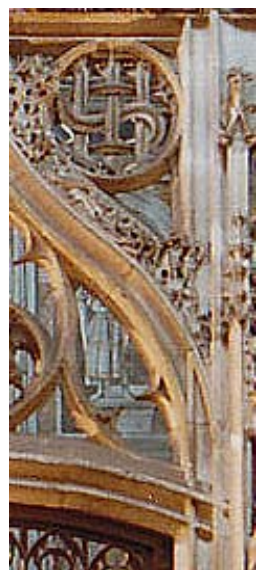
Bild III.52: Albi, Kathedrale, Chorschranke 1474-1483. Stabüberschneidung im Bereich der Kämpferpunkte.
