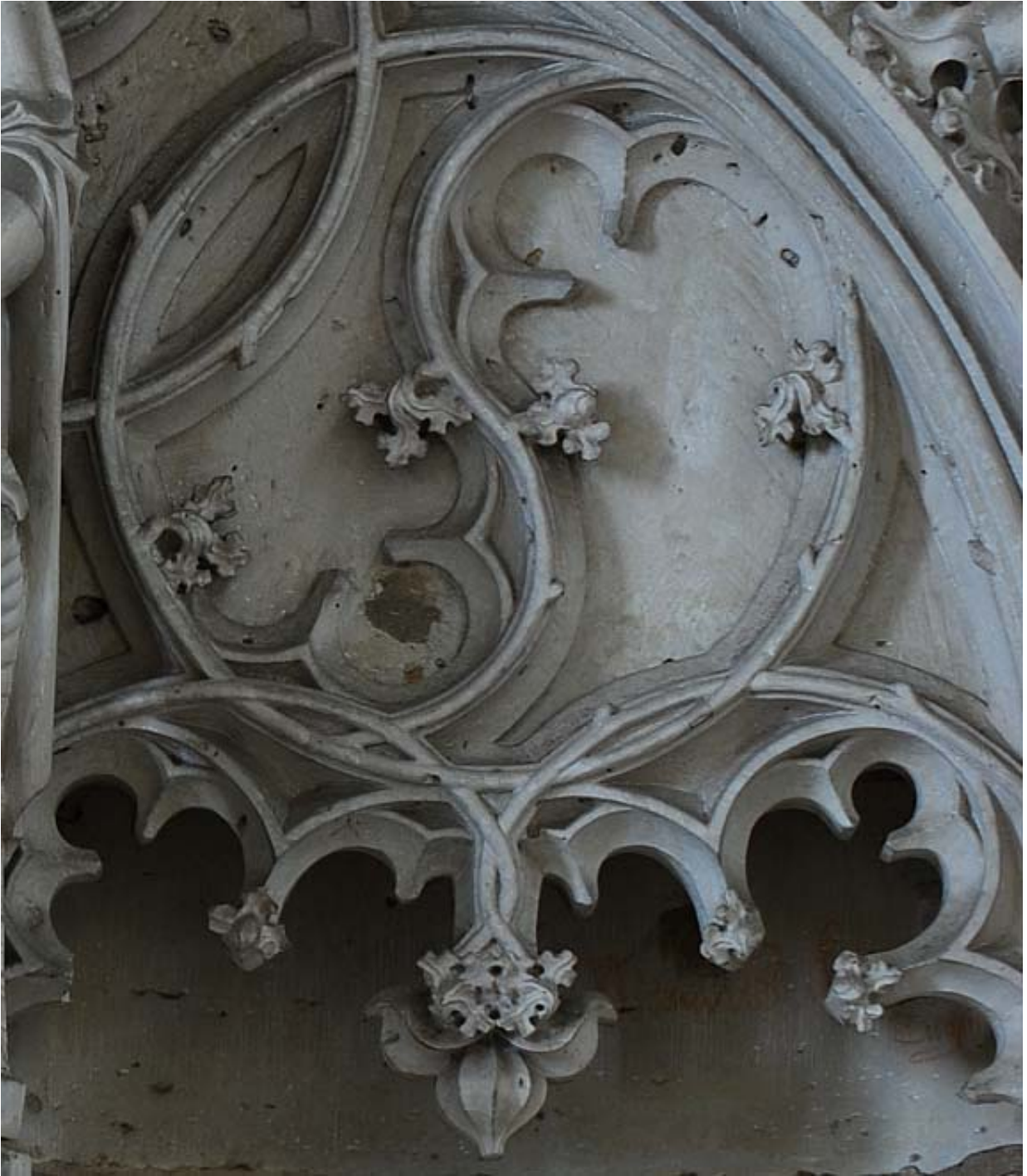
Bild III.39: Detail aus Bild III.38. Rutenmaßwerk mit Blättern und Eicheln. Mittlere Nase mit Blättern und Knospe. Die Scheitelachsen der hängenden Nonnenköpfchen sind gegensinnig aus der Vertikalen rotiert.
