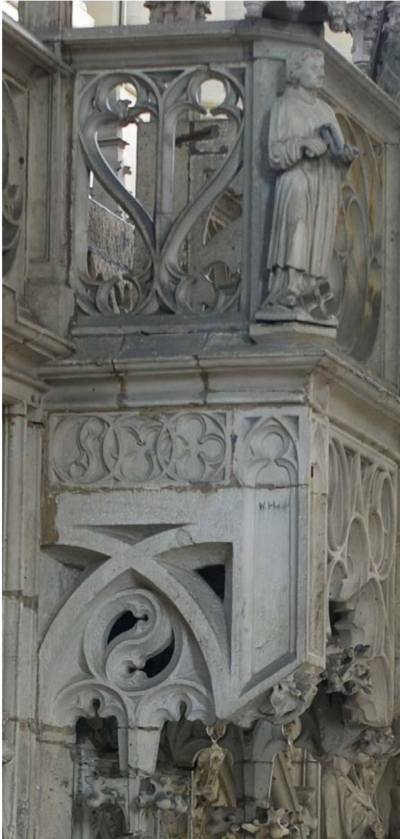
Bild III.19b: Maßwerk der nördlichen Kanzelbrüstung und des Ziboriums.
