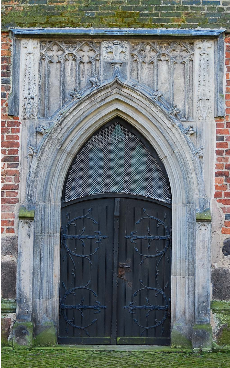
Bild III.44: Stendal, Nikolaipforte im nördlichen Querhaus von St. Nikolai (Dom). Kielbogenüberdachtes Spitzbogenportal ohne Profilüberschneidung.
