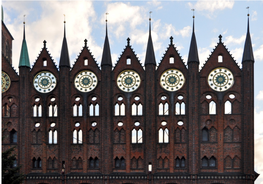
Bild II.38: Stralsund, Gotische Schaufassade des Rathauses auf dem Alten Markt. Durch Fialen und Wimperge, die über den Dachfirst hinaus ragen, wird ein Luftgeschoss gebildet, 13. Jahrhundert.
