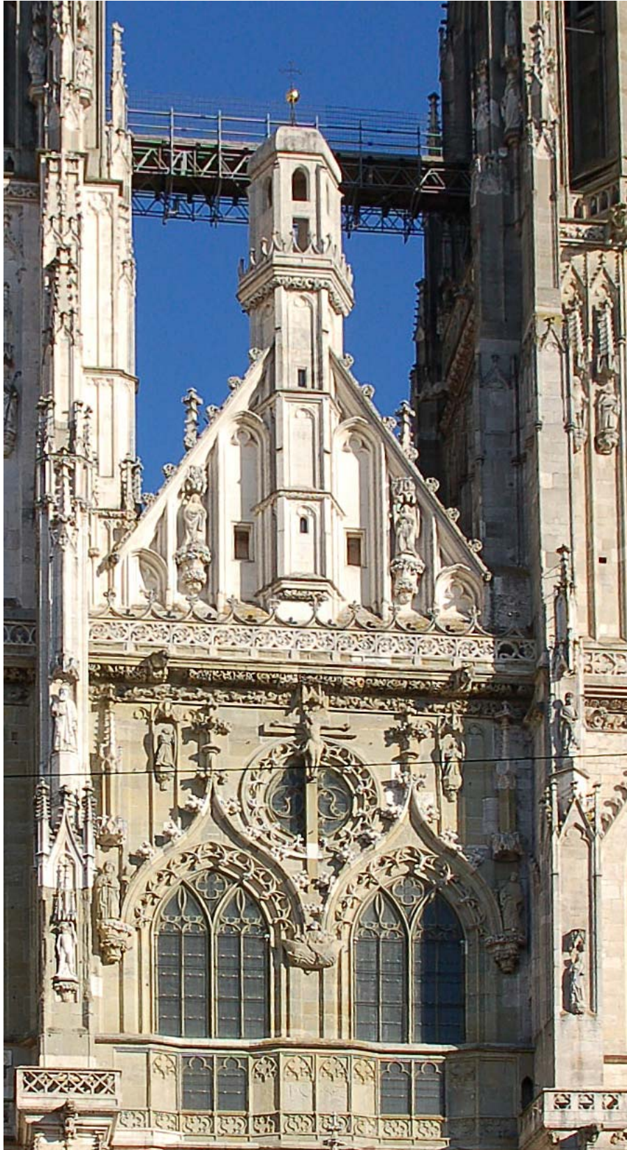
Bild III.54: Regensburg, Dom, Westfassade, 2. Geschoss des Mittelbaus. Von Kielbogen überfangene Spitzbogenfenster. Die Kielbögen stehen im Kämpferbereich auf Konsolen. Keine Profilüberschneidungen. Verzierung der Spitzbogenprofile durch einen Rundbogenfries auf dem Profil des mittleren Spitzbogens. Dieses Motiv findet sich auch am Portal der Marienkapelle des Remters im Magdeburger Dom.
