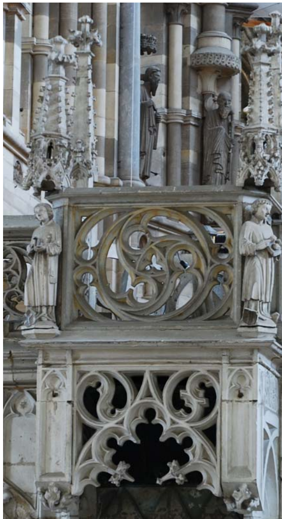
Bild III.19a: Maßwerk der vorderen Kanzelbrüstung und des Ziboriums.
