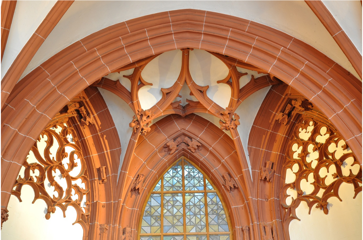
Bild III.32: Frankfurt/Main, Dom St. Bartholomäus. Madern Gerthener: Schleiermaßwerk am Gewände des Turm-Nordportals, um 1422/23.
