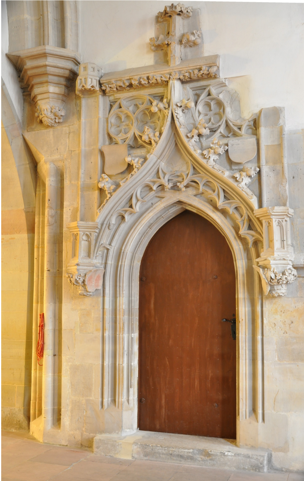
Bild III.36: Magdeburg, Dom, Marienkapelle. Schleiermaßwerk unter einem Kielbogen.
