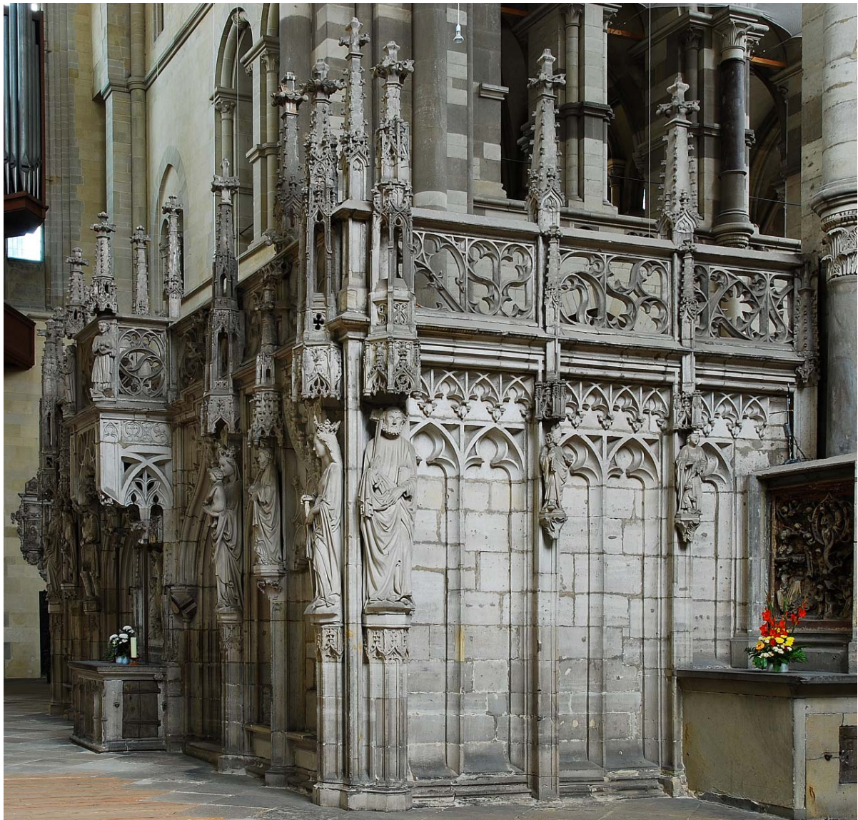
Bild II.3: Blick auf den Lettner von SW. An der SW-Kante nach Süden gewandt der Apostel Petrus. An der Südwand die kleinen Figuren Nikolaus und Elisabeth. Brüstungsfialen vom Typ I kennzeichnen die Standorte der kleinen Figuren. Brüstungsfialen vom Typ II über der NW- und SW-Kante des Lettners, an den hinteren Ecken der Kanzel und am Standort der mittelgroßen Figuren. Fialen vom Typ III stehen über den Baldachinen der großen Figuren vor der Lettnerwand. Den Typ IV bilden die Baldachinfialen der Diakone an der Kanzel.
