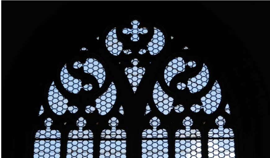
Bild III.23: Görlitz, Dom St. Peter und Paul, nördliches Seitenschiff, Doppelschneuß im Kreis, gestützt von zwei Fischblasen, vor 1497.
