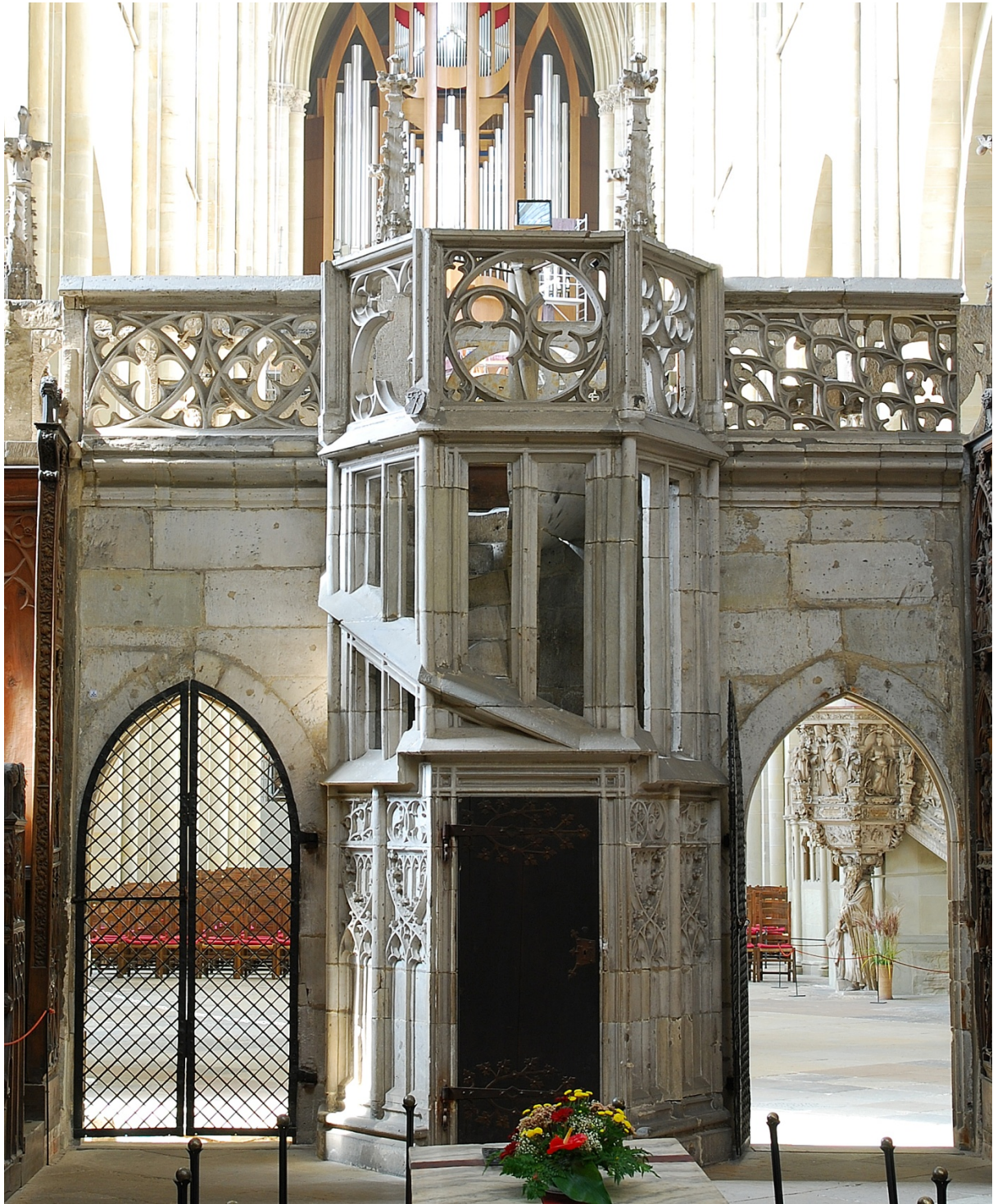
Bild II.5: Mittelteil der Ostansicht des Lettners mit dem Treppenturm zur Kanzel.
