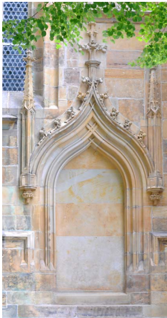
Bild III.50: Erfurt, Dom. Ehemalige Taufpforte, um 1463. Mit Krabben besetztes Kielbogenportal mit Profilüberschneidungen im Scheitel und im Bereich des Kämpferpunktes.
