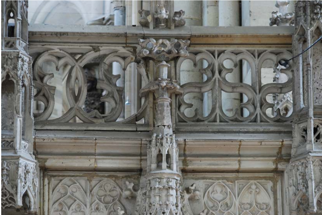
Bild III.18. Maßwerk der Brüstungsfelder Wg und Wh.
