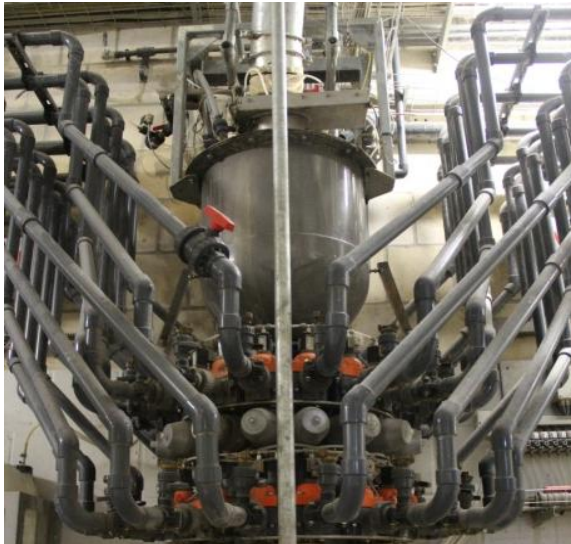
Abb. 5: Mischbehälter der Flüssigfütterung Zuteilung des Futters erfolgt buchtenweise computervermittelt durch pneumatisch gesteuerte Ventile (Sonderanfertigung)
