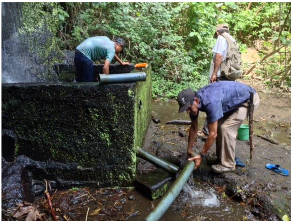
Foto 4. Limpieza de la pila de captación por integrantes del CAPS El Edén
