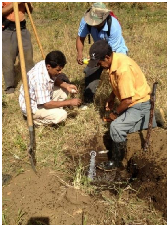
Fotos 8 y 9. Corte de agua realizado por el CAPS El Edén Elaboración propia, 21.3.14
