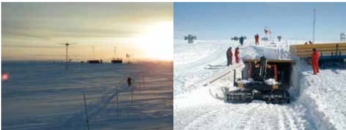
Abb. 10 Georg-von-Neumayer-Station II im Jahr 1999, in dem sich die Station bereits unterirdisch befindet, in Abb. 11 ist der Zugang für die Fahrzeuge dargestellt (5)
