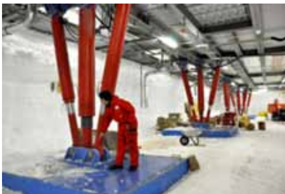
Abb. 14 Hydraulikfundamente der Georg-von-Neumayer-Station III (5)
