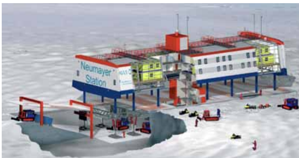
Abb. 13 Schematische Ansicht der Georg-von-Neumayer-Station III (5)
