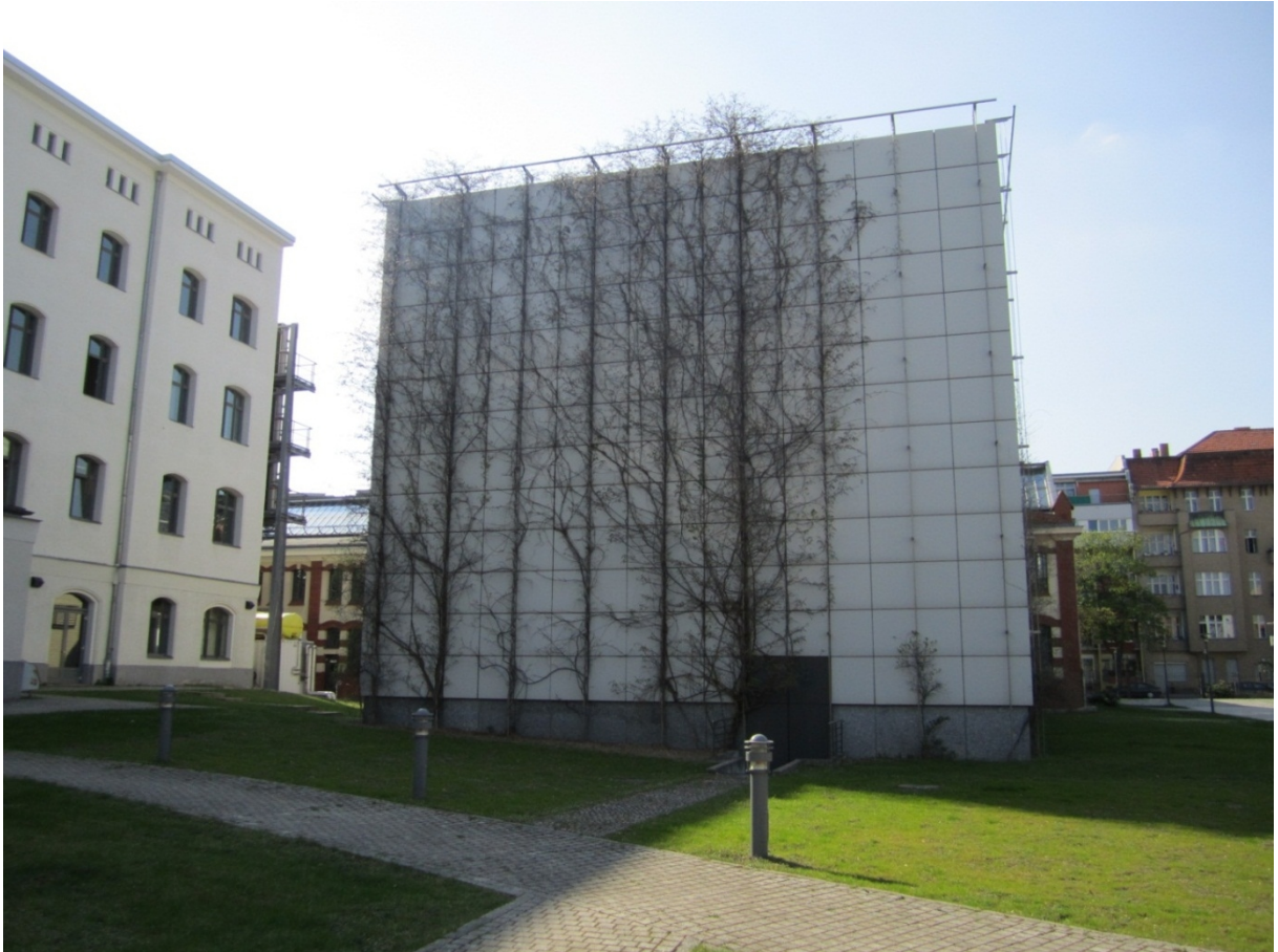
Abbildung 3.2: Das Gebäude mit dem BMSR-2.
