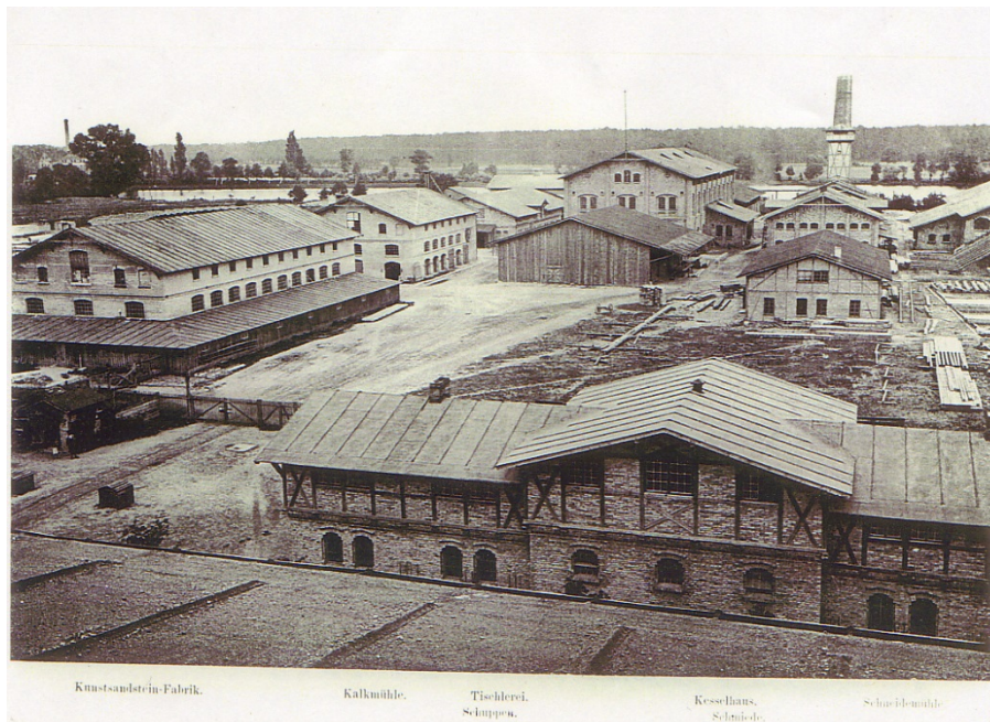
Fig. A 8: Kunstsandsteinfabrik von Schulz. Foto: Heimatmuseum Treptow, 2003
