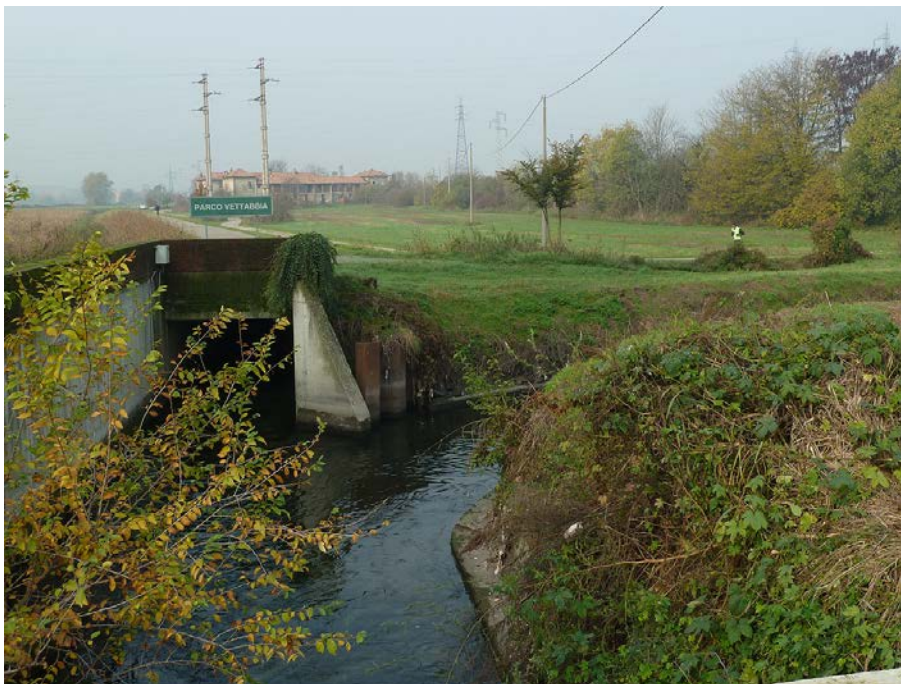
Fig. 9-3: Blick über die einstigen Rieselfelder, die heute dem Mailänder Klärwerk Nosedo nachgeschaltet sind. In der unteren Bildhälfte ist der Auslauf des von Klarwasser gespeisten Grabens oberhalb des Lambro zu sehen. Foto: Winklhöfer November 2012
