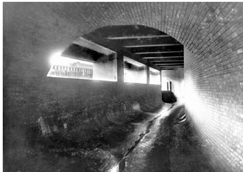
Fig. 3-32: Notauslass an der Friedrichsbrücke (Spree). Foto: Eduard Kruse 1925.
