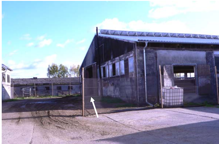
Abbildung 21: Netzfreier Zufahrtsweg und Deltamethrinhaltiger Polyester-netzzaun an der Vorderseite des Interventionsstalls auf der Milchviehanlage in Lögow, Landkreis Ostprignitz-Ruppin, Brandenburg 2009.
