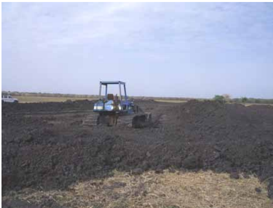
Foto 5-6a/b: Arbeiten am Maya Beit al Wahash. Das Maya wird künstlich vertieft, um dem natürlichen Verlandungsprozess entgegenzuwirken. Auf diese Weise soll mehr Wasser gespeichert werden und damit über einen längeren Zeitpunkt für die Tiere zur Verfügung stehen.
