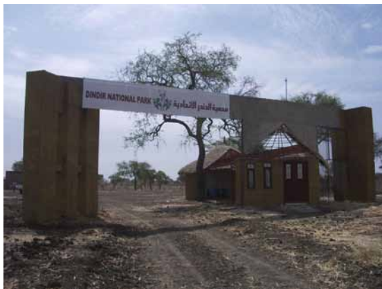
Foto 5-47: Das gerade fertig gestellte Eingangstor zum DNP
