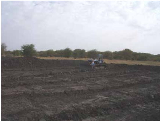
Foto 5-6a/b: Arbeiten am Maya Beit al Wahash. Das Maya wird künstlich vertieft, um dem natürlichen Verlandungsprozess entgegenzuwirken. Auf diese Weise soll mehr Wasser gespeichert werden und damit über einen längeren Zeitpunkt für die Tiere zur Verfügung stehen.
