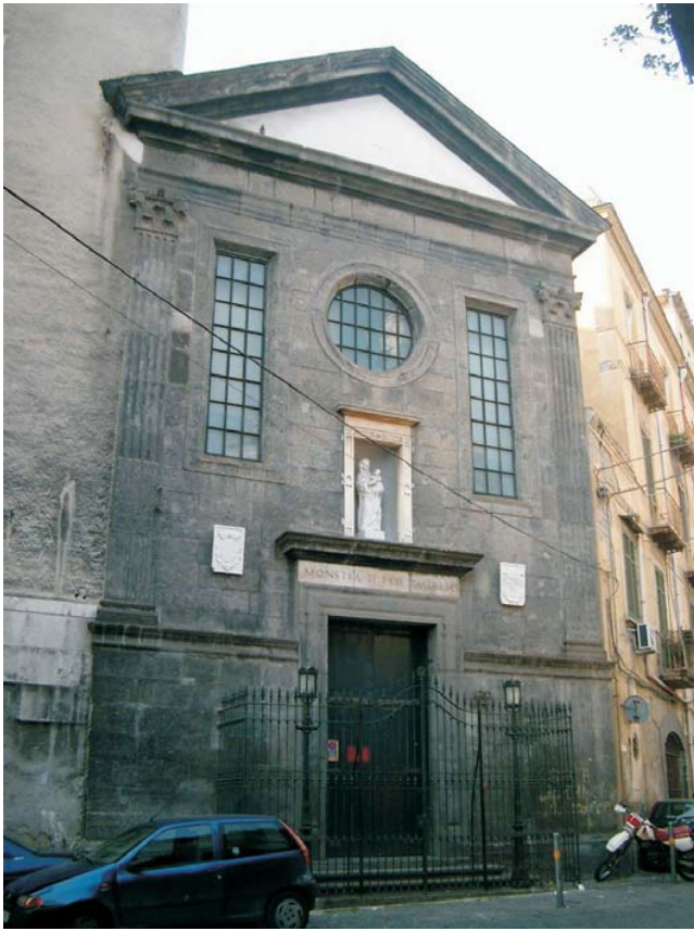
168. S. Maria Materdomini, Fassade
