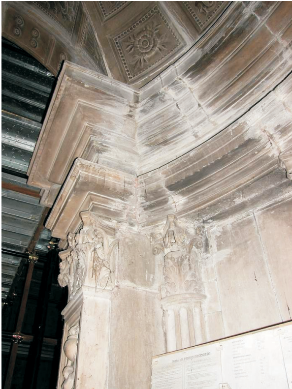
151. S. Maria dei Pignatelli, Seitenkapelle (Detail der Baunähte der Seitenkapelle)
