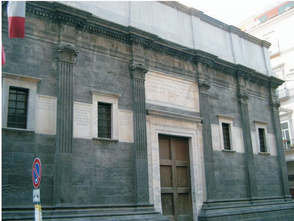
166. Cappella Pontano, Fassade
