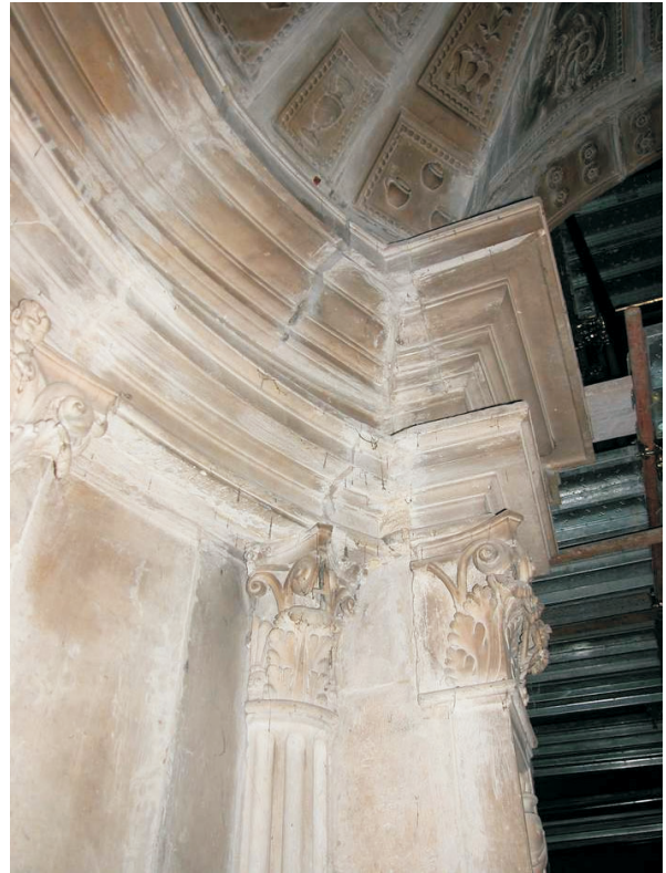
152. S. Maria dei Pignatelli, Seitenkapelle (Detail der Baunähte der Seitenkapelle)
