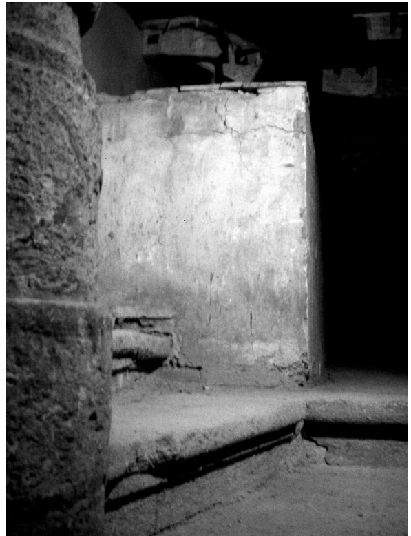
153. S. Maria dei Pignatelli, Seitenkapelle (Detail der äußeren Verschalung)
