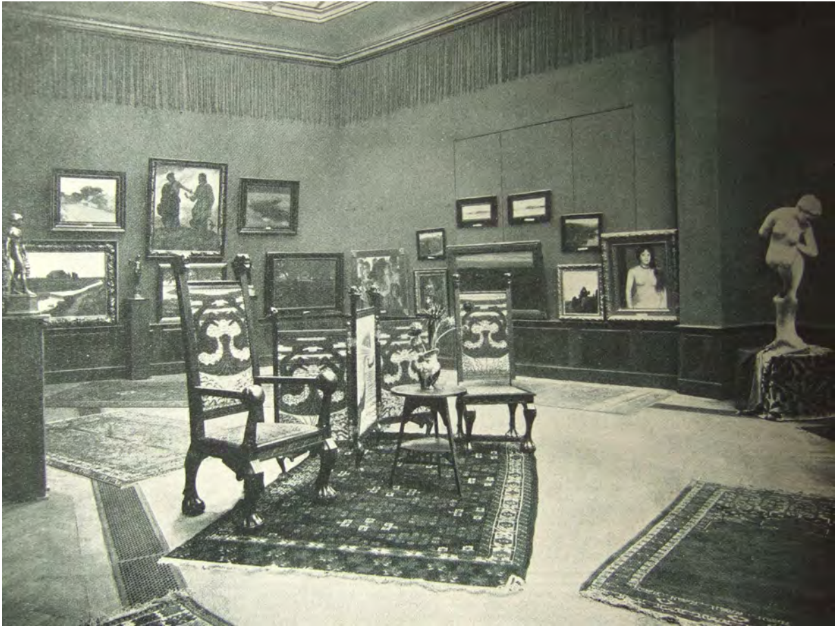
Abb. 105: Großer Oberlichtsaal bei Keller & Reiner nach Umbau 1898.
