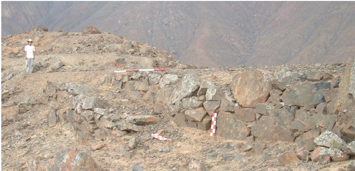
Abbildung 108: Bruchsteinmauerwerk ohne Lagen bei der westlichen Stützmauer der großen Terrasse (rechts) mit z.T. verstürztem, vorgelagertem Treppenaufgang (Nordpfeil) im unteren Sektor 3 von PV44-P/13 in Huanchuy (großer Maßstab 2 m und kleiner Maßstab 30 cm).
