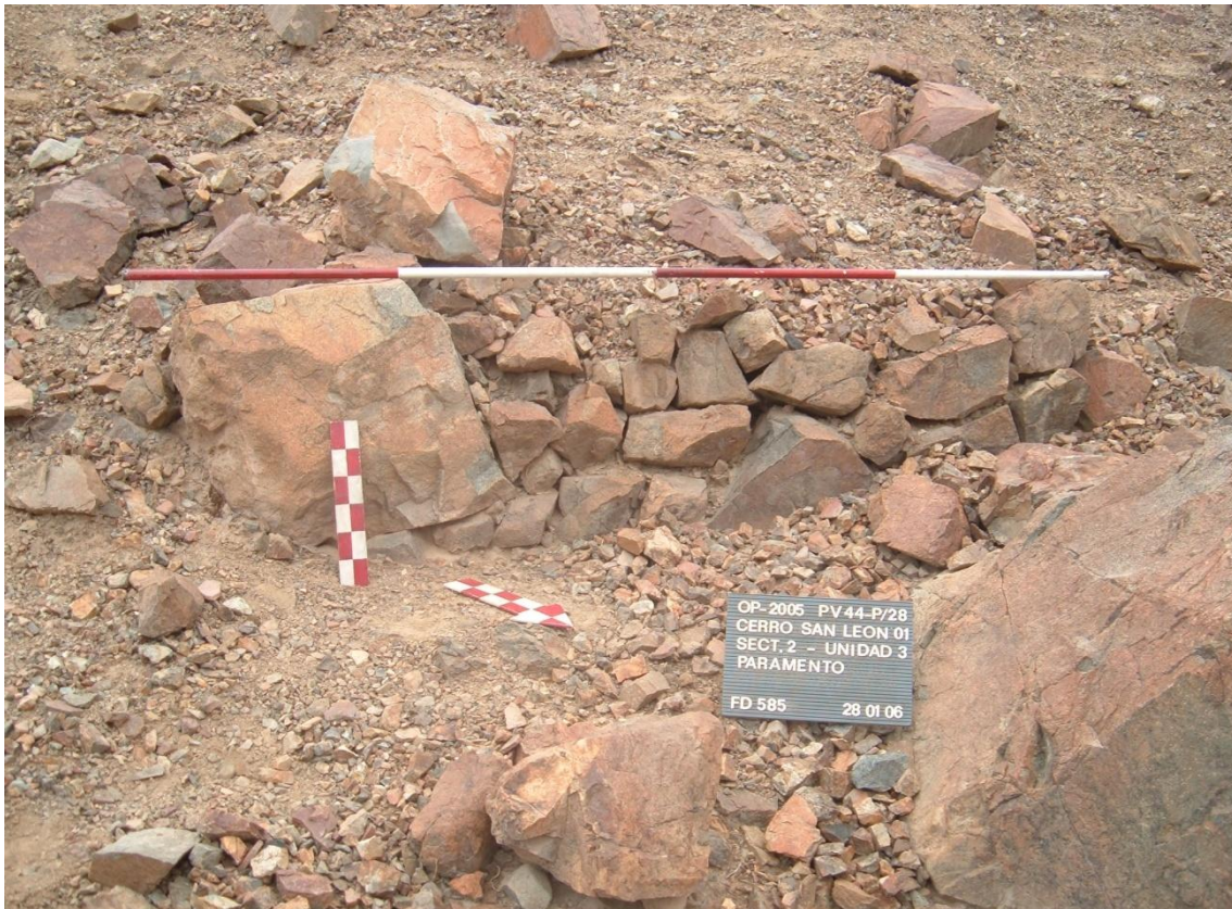
Abbildung 67: Unregelmäßiges Bruchsteinmauerwerk einer Terrassenstützmauer im Sammelareal 3 in PV44-P/28 Sektor 2 in Huanchuy (großer Maßstab 2 m und kleiner Maßstab 30 cm). Man beachte den größeren Felsbrocken links, der in das Mauerwerk eingepasst wurde.
