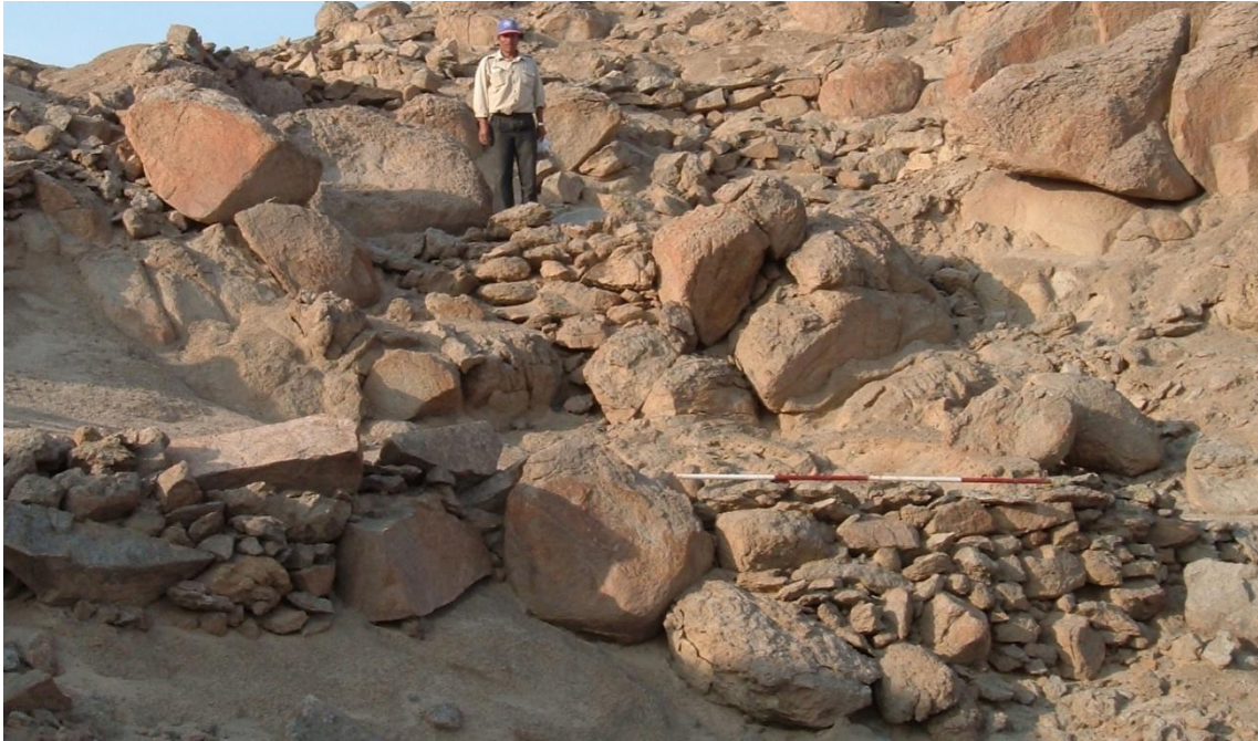
Abbildung 119: Blick gegen Nord auf einen Komplex von Terrassenstützmauern mit unregelmäßigem Trockenmauerwerk im Sektor 1 von PV44-O/32 in Quilca (Maßstab 2 m).
