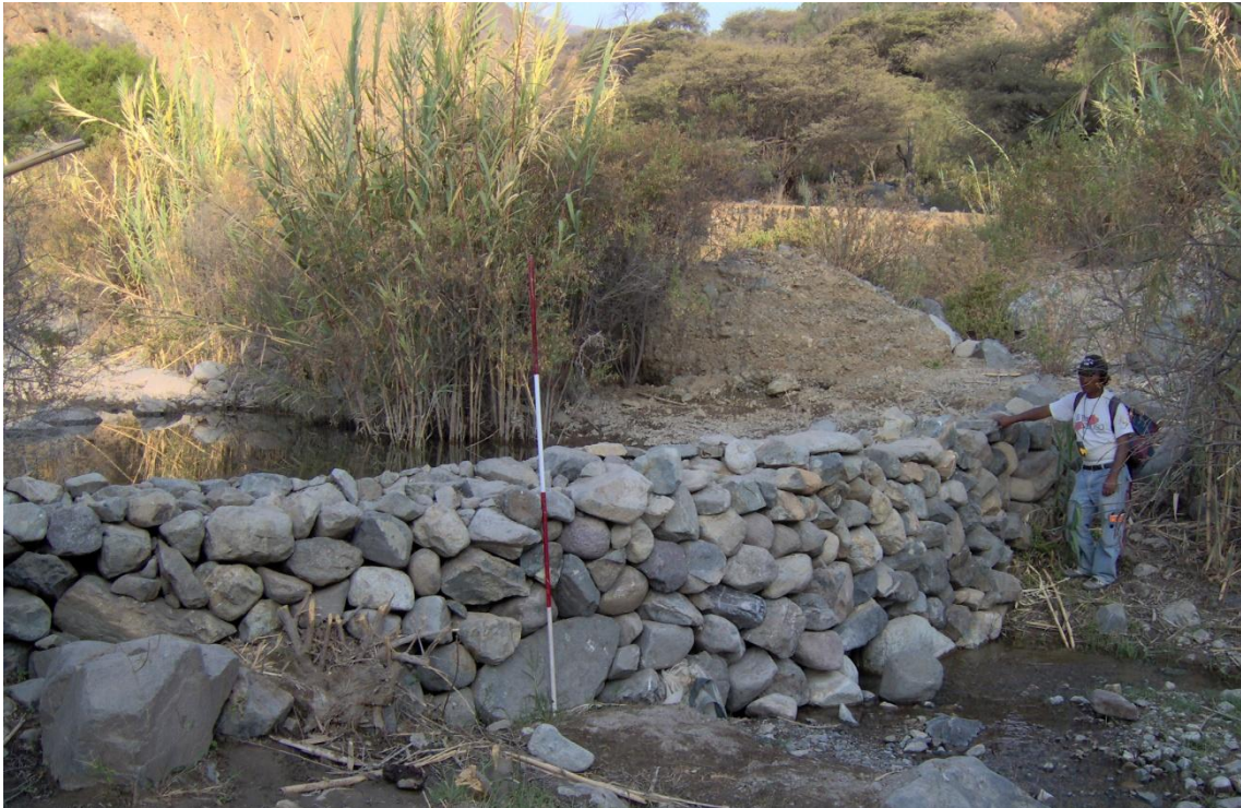
Abbildung 26: Blick gegen Südosten auf die Staumauer im Flussbett bei Shimay.
