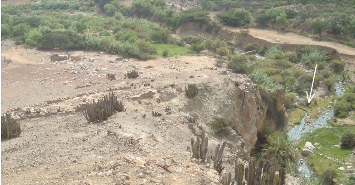
Abbildung 24: Blick gegen Westen auf die Abzweigstelle in den südlichen Bewässerungskanal von Ayacoto unterhalb der Quelltöpfe. Auf dem Felssporn links die inkazeitlichen Gebäudereste im Sektor 3 von PV44-P/33.
