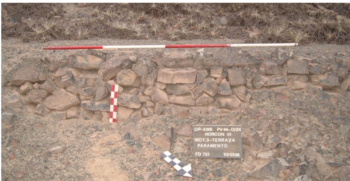
Abbildung 118: Bruchsteinmauerwerk ohne Lagen bei einer Terrassenstützmauer im Sektor 3 von PV44-O/24 in Orcón (großer Maßstab 2 m und kleiner Maßstab 30 cm).
