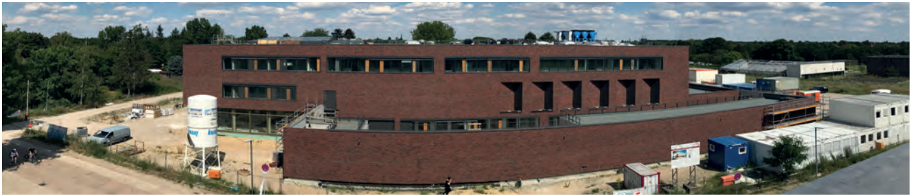
Bild 1: Die Baustelle des TZR im Juli 2020
