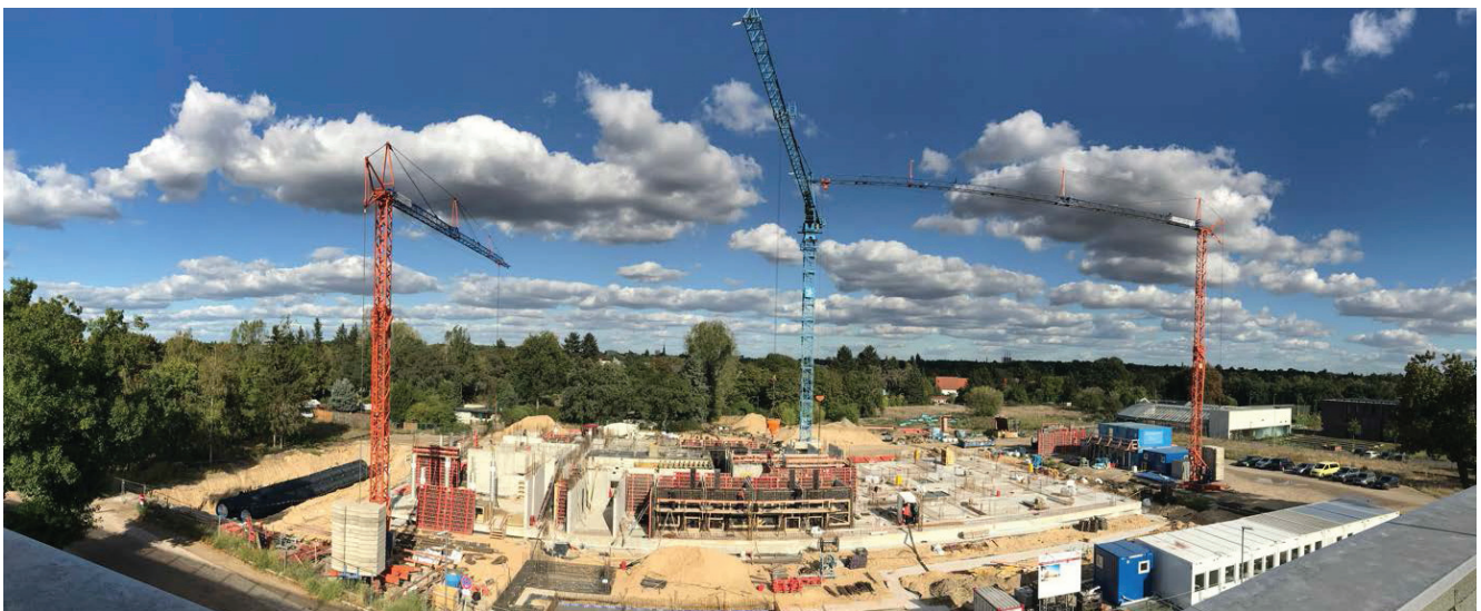
Bild 7: Die Baustelle Ende September 2018 mit Sicht auf die Tierhaltungsräume
