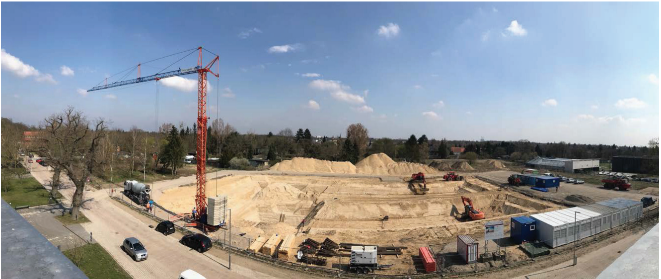
Bild 6: Die Baugrube Anfang April 2018
