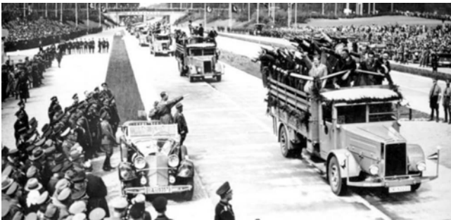
Abb. 45: Foto der ersten Reichsautobahn 1935, An der Brücke im Hintergrund steht »Darmstadt«, möglicherweise wurde auch hier ein »Nieder mit Hitler« des ISK in letzter Minute übermalt; Foto: 3. Reich/ Bundesarchiv.
