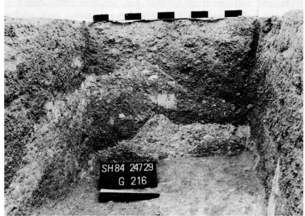
135 Östlicher Kanal bei Tall Šēh Hamad; Testschnitte im westlichen Kanaldamm; Aufnahmen 1984 von Norbert Grundmann
