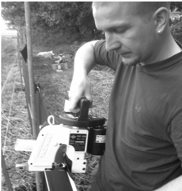
Abb. 4: Vernähung des Netzmaterials mit dem vorinstalliertem Elektrobreitband
