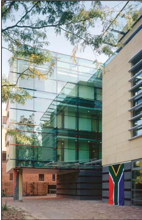
Abb. 8.17: Vorkragender Gebäudeteil der Nordfassade der Botschaft Südafrikas (Foto R. GÖRNER für MMA ARCHITECTS)
