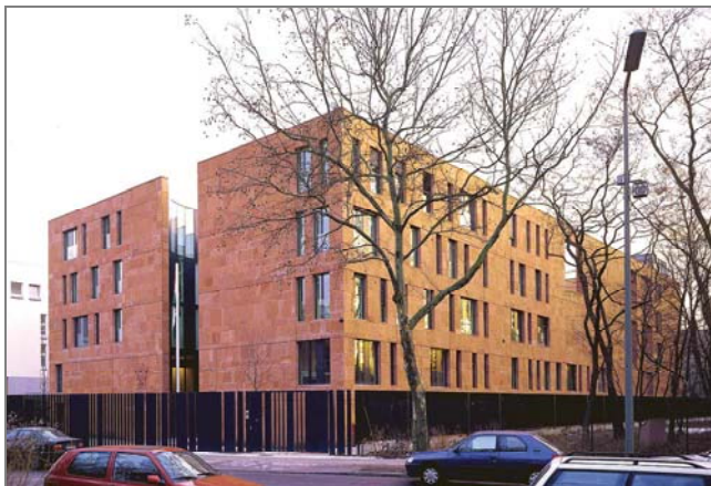
Abb. 8.2: Die Botschaft der Republik Indien, Ansicht von Norden (Foto: C. RICHTERS für LÉON WOHLHAGE WERNIK ARCHITEKTEN)
