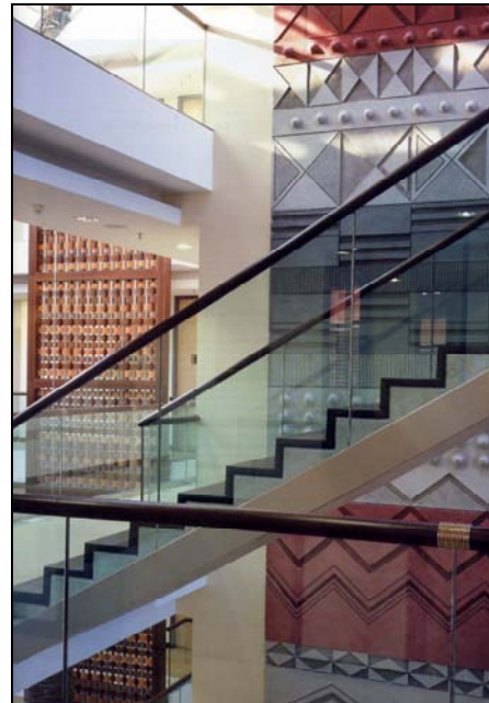
Abb. 8.20: Holzflechtwerk und Putz im Treppenhaus der südafrikanischen Botschaft (Foto R. GÖRNER für MMA ARCHITECTS)
