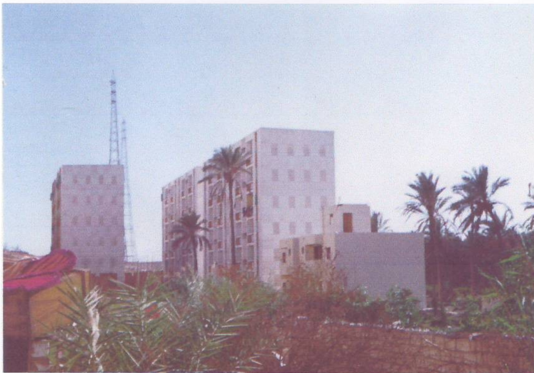
Bild 8: Das Hai As-Salam (hohe Gebäude im Bildmittel- und Hintergrund) am südlichen Stadtrand von Rashid ist von der Regierung auf Acherboden gebaut worden. Diese meist 5 bis 7 Stockwerke hohen Sozialbauten wurden errichtet, um den Bewohnern von Rashid Wohnraum zur Verfügung zu stellen, aber auch, um die Preise auf dem Immobilienmarkt für Wohnraum durch Hochhausbauten zu kontrollieren. Das kleinere weiße Gebäude und die braune Hütte im Vordergrund sind illegal errichtete Wohnstätten.
