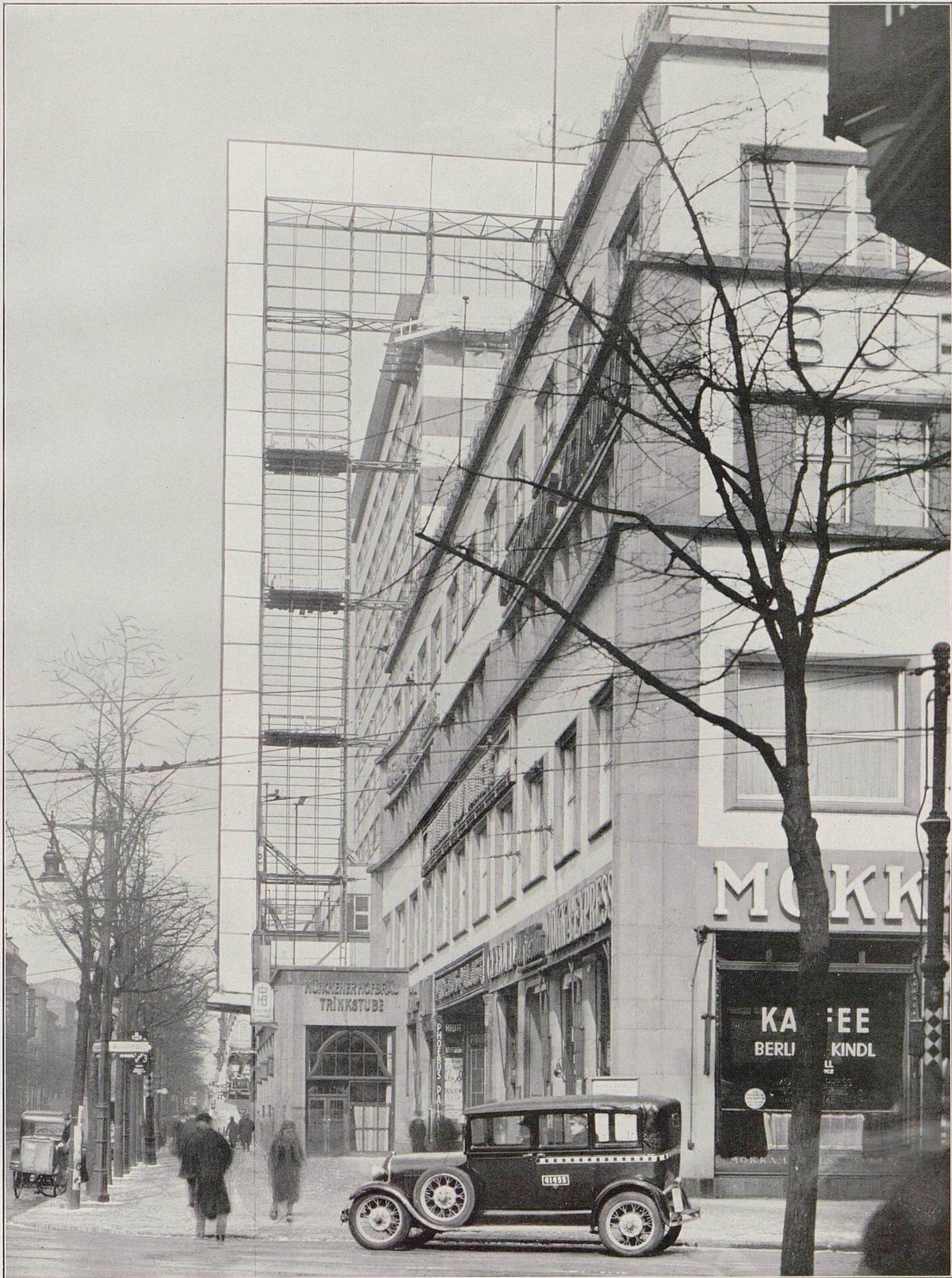
*Der Lichtreklameturm mit der Flossenverkleidung für die Leuchtbeschriftung*
