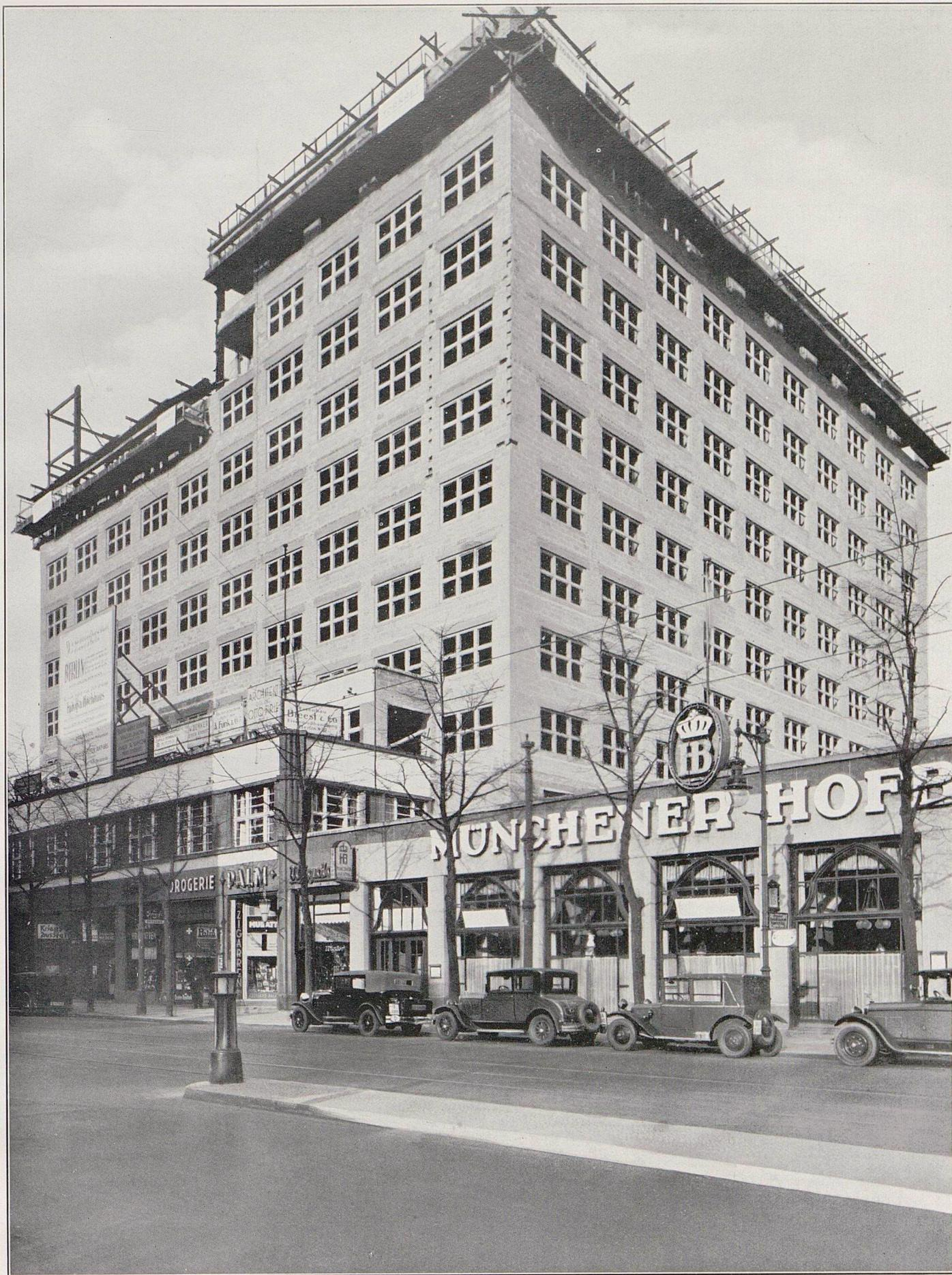
*Da bei der neuen Bauweise die Baufeuchtigkeit eine ganz geringe ist, konnten sofort die Fenster eingesetzt werden*
