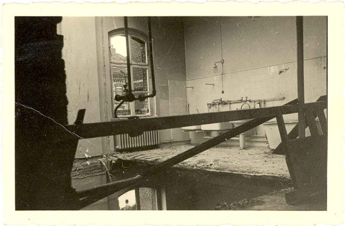
Abbildung 33: Bombenschäden im Kinderkrankenhaus Wedding, 1945 (?).
