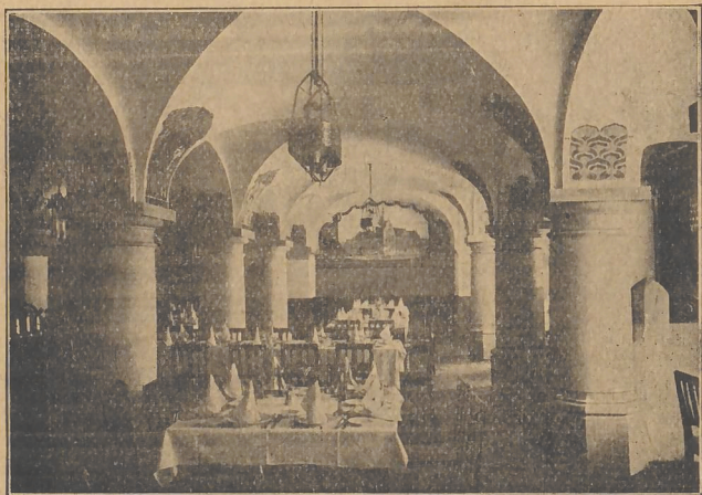
Blick in den Ratskeller. Aufnahme 1905.
