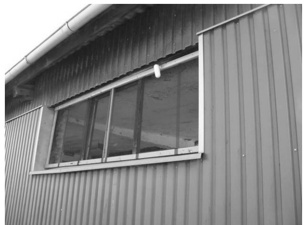
Abbildung 5: Mit insektizidhaltigem Netzmaterial ausgerüstetes Fenster auf der Milchviehanlage in Eichstädt, Landkreis Oberhavel, Brandenburg, 2008.
