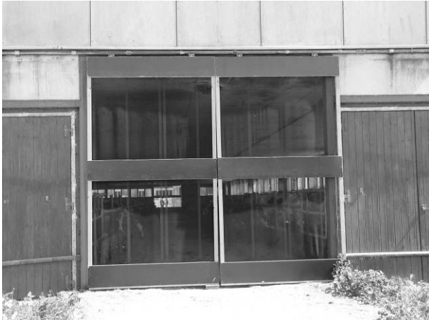
Abbildung 2: Mit insektizidhaltigem Netzmaterial ausgerüstetes Rolltor im Stall 4 auf der Milchviehanlage in Lögow, Landkreis Ostprignitz-Ruppin, Brandenburg, 2008.
