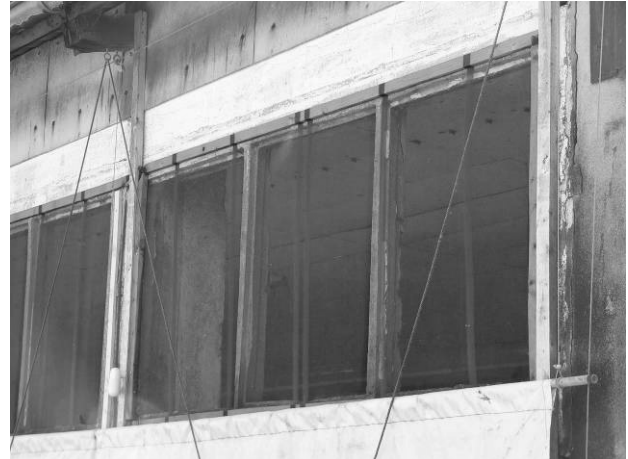
Abbildung 3: Mit insektizidhaltigem Netzmaterial ausgerüstetes Fenster im Stall 4 auf der Milchviehanlage in Lögow, Landkreis Ostprignitz-Ruppin, Brandenburg, 2008.
