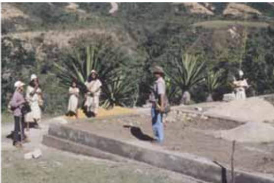
Construcción de una escuela (1993)
