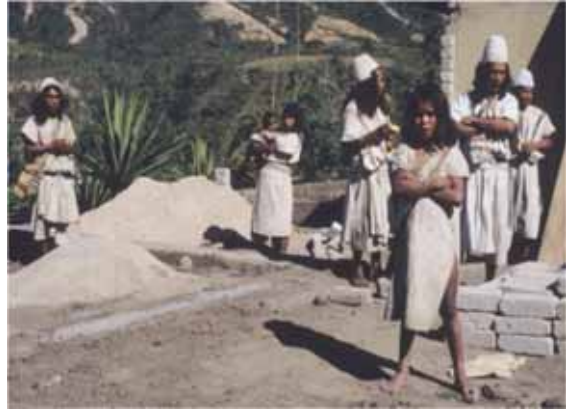
Construcción de una escuela (1993)
