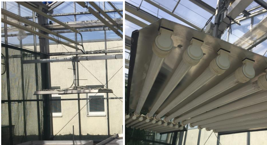
Abb. 10: Breitbandige UV-Quellen am Gießwagen (eigene Fotos)
