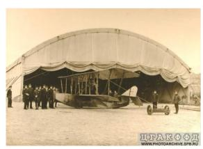
Подготовка аппарата к транспортировке по спуску в море.
