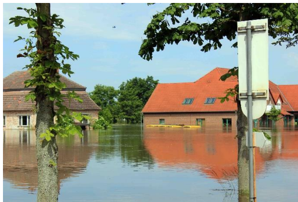
Bild 8: Überschwemmte Häuser (Zur Verfügung gestellt von der Gemeinde Schönhausen)
