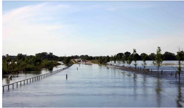
Bild 10: Brücke unter Wasser
