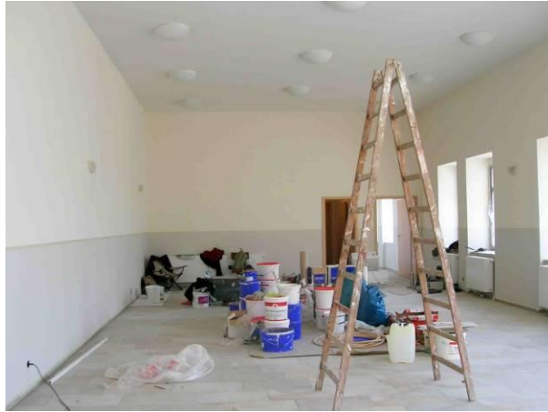
Bild 32: Renovierungsarbeiten (Bettina Wenzel, Katastrophenforschungsstelle)
