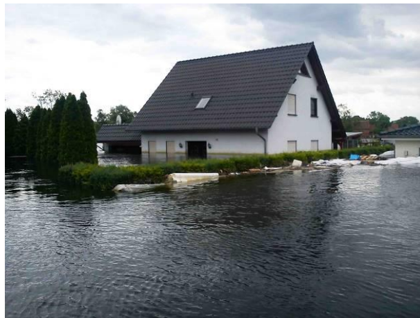
Bild 27: Ausgeschwemmter Hausstand (Zur Verfügung gestellt von der Gemeinde Schönhausen)
