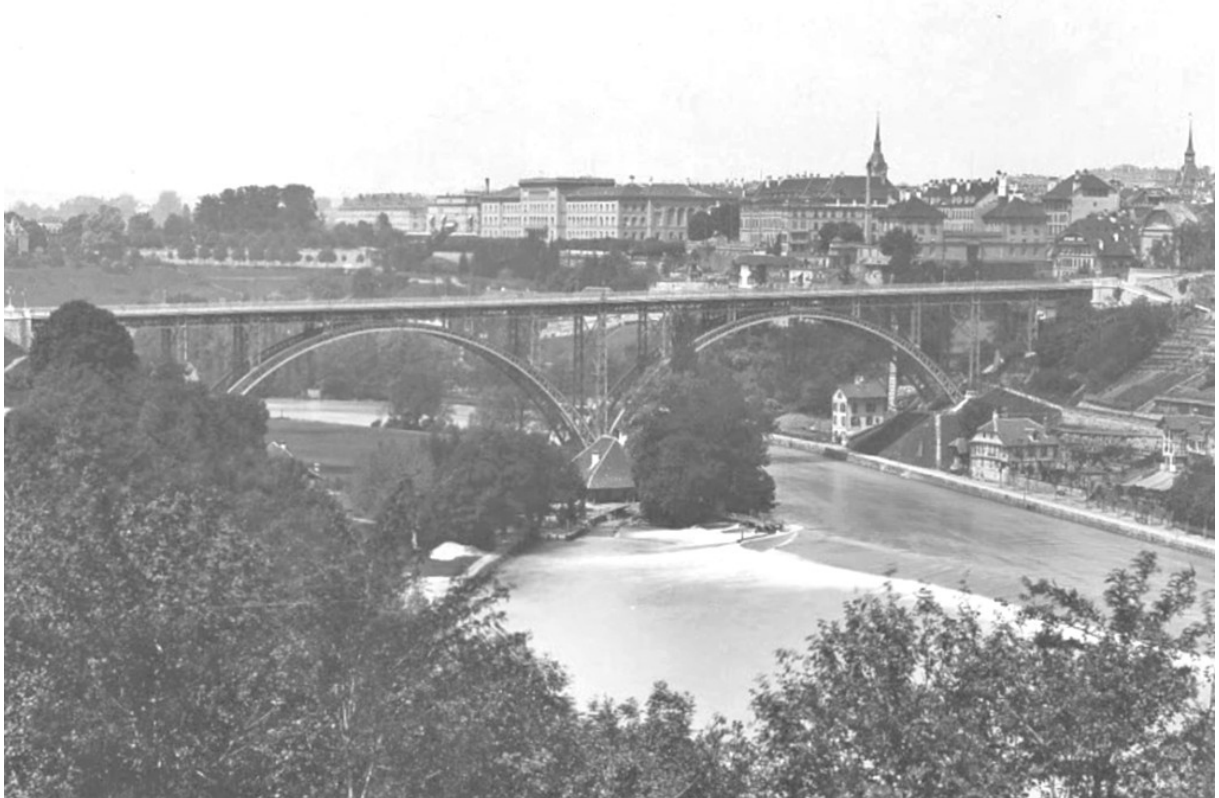
Abb. 20: Ansicht von Südosten, Bundesrathaus.
