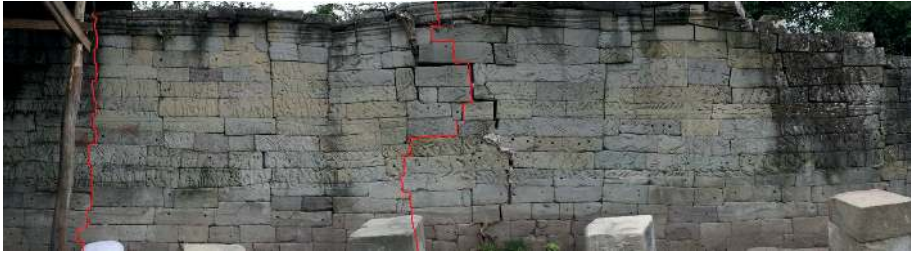
Abb. 5 Die östliche Mauer in ihrem ursprünglichen Zustand. Die Steine, im Bild durch die roten Linien begrenzt, wurden digital vermessen.
