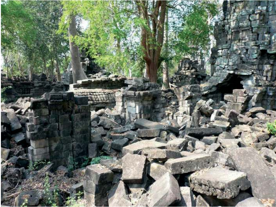
Abb. 2 Aktueller, zerfallener Zustand der von Jayavarman VII erbauten Tempelanlage.
