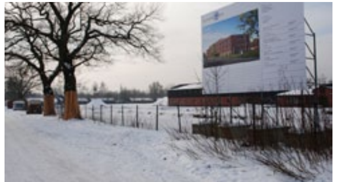
Bauplatz des Robert von Ostertag-Haus im Februar 2010 (Foto: Frank-Michael Weigner)
