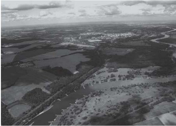
Abb. 18 Oberblick von Süden nach Norden mit Lossow im Vordergrund.
