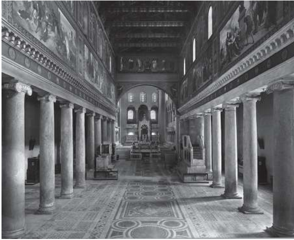
Abb. 6 Rom, S. Lorenzo fuori le mura, Langhaus begonnen um 1195.
