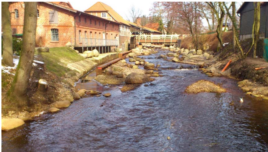
Abb. 4. Sohlgleite am ehemaligen Mühlenwehr in Sittensen.
