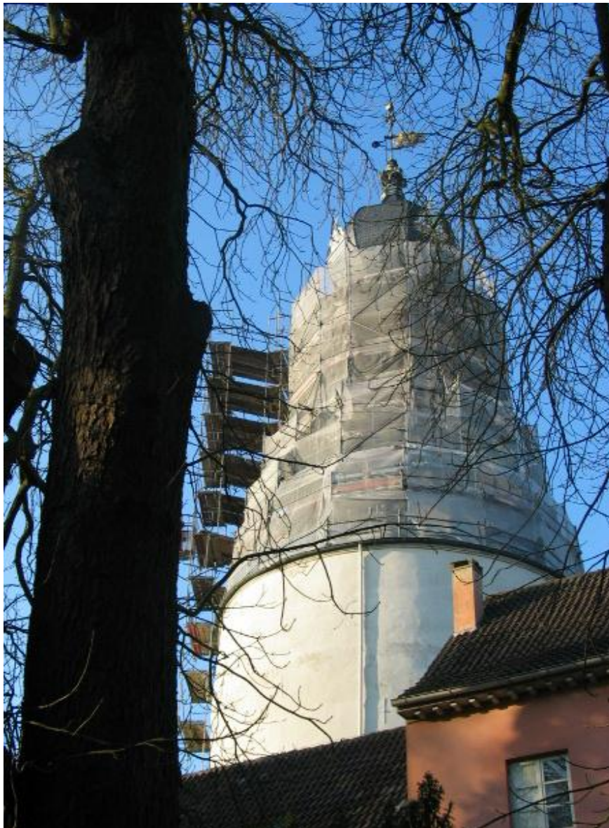
Abb. 1. Eingerüsteter Schlossturm, Restaurierung 2016.
