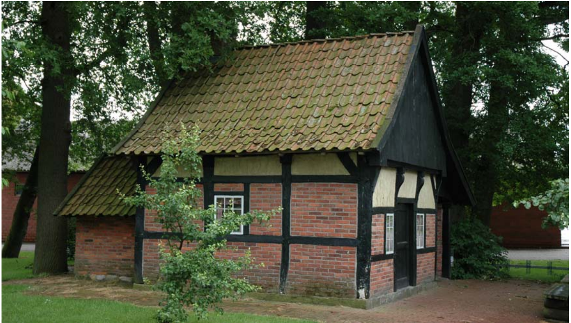
Abb. 4. Das kleine Backhaus in Lünne-Heitel diente einst als Hofbackhaus und wird seit seiner Restaurierung für Backvorführungen und als Buswartehäuschen genutzt.
