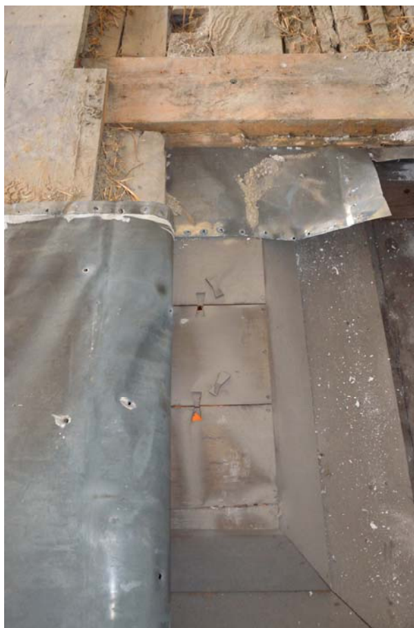
Abb. 2. Blick in den Aufbau der Kassettendecke vom Fußboden der oberen Etage.
