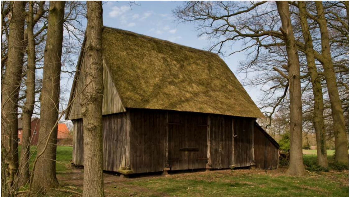
Abb. 3. Ein ganz seltenes Beispiel der früher weit verbreiteten „mäusesicheren“ Pfeilerscheunen steht bis heute im Salzbergener Ortsteil Steide.
