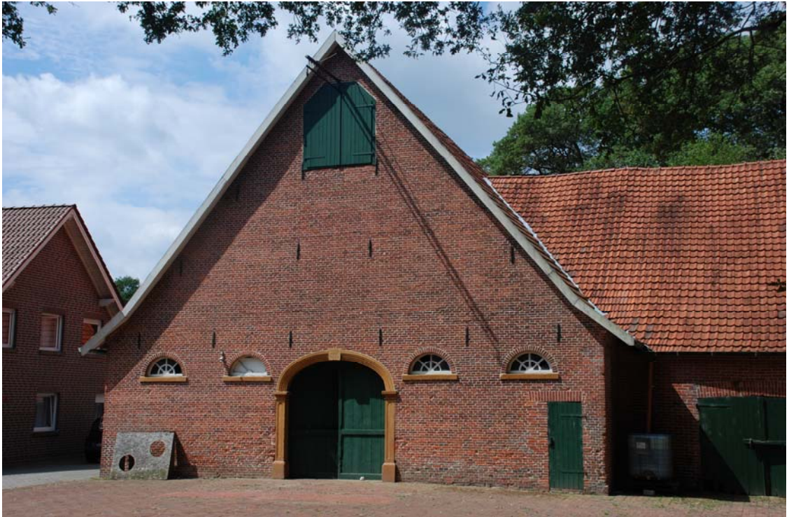
Abb. 2. Niederdeutsches Hallenhaus von 1857 in Massivbauweise in Ahmsen.
