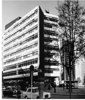
Die Ecklösung, Einmündung der Hardenbergstraße
