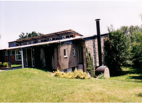
Der Kamin und Schornstein an der Außenfront
