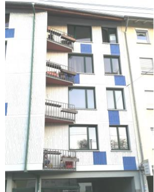
Lerchenstraße, rechts davon der Anschnitt einer Standardlösung des Mietwohnungsbau der Zeit
