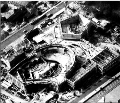
Der Einblick in das Gebäude während der Bauzeit
