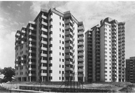
Die Gebäudegruppe - Abbildung zum Zeitpunkt der Fertigstellung
