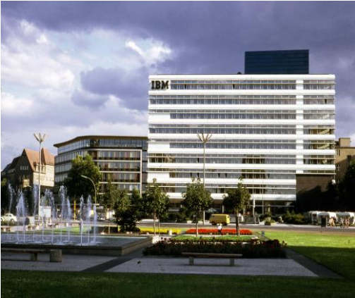
Der Blick geht auf die dem Ernst-Reuter-Platz zugewandte Fassade
