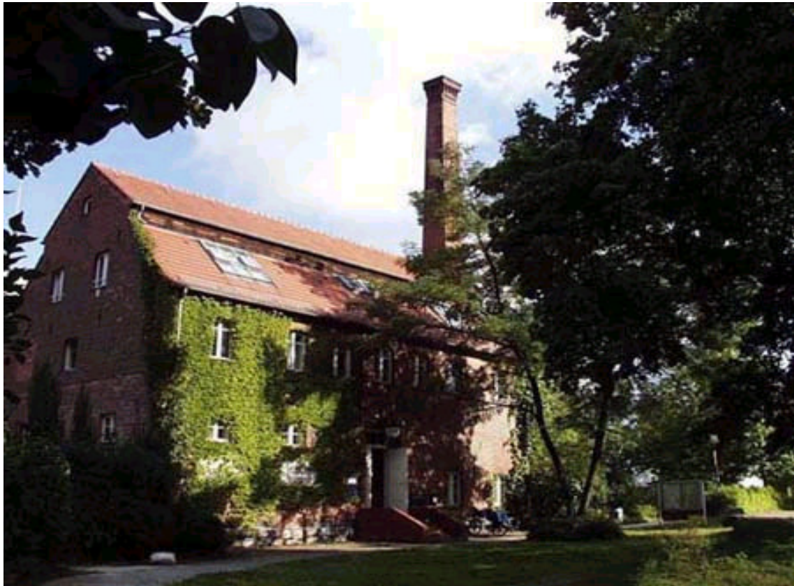
Das Dekanat auf dem Campus Düppel, die „Alte Brenneri“.
