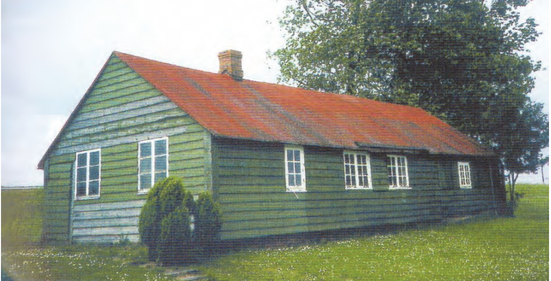
Abb. 4. Noch in 1970er Jahren erinnerte in Fedderwardsiel eine Baracke (Wohn- oder Küchenbaracke?) an die Notstandsarbeiten (an dieser Stelle befindet sich heute das Bürogebäude der Bauunternehmung Haye).
