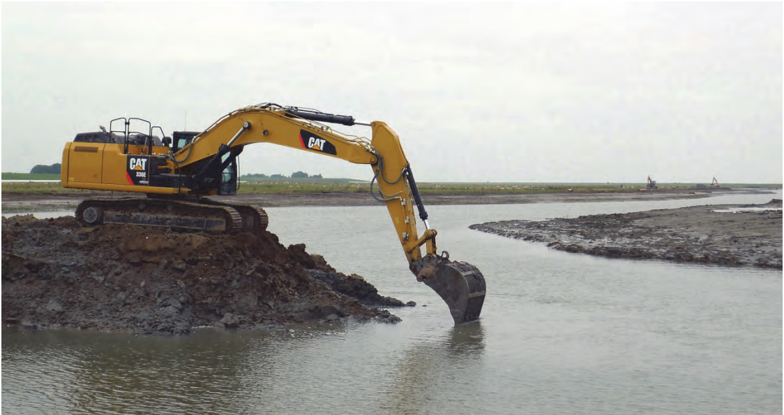
Abb. 11. Durchstich zum ausgebauten Binnentief.
