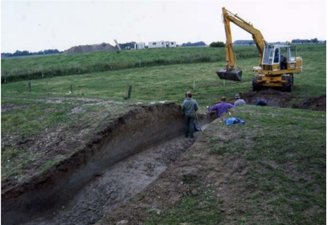
Abb. 3. Ausgrabungsarbeiten an einem historischen Deich des 12. Jahrhunderts im Bereich der Haukenwarf, Gde. Wangerland (Foto: J. Ey, NIhK).
