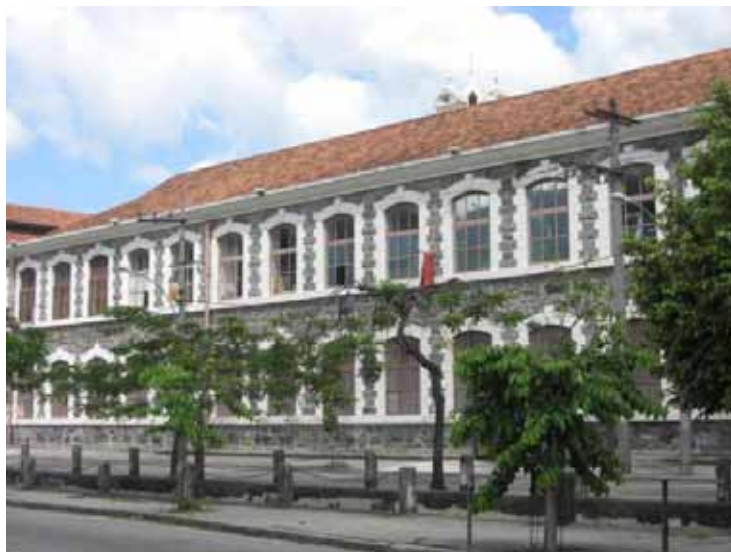
Figura 3: Fachada lateral da Fábrica Confiança e rio Joana, no bairro de Vila Isabel.
