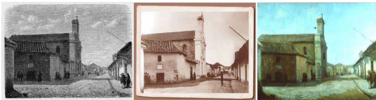
Fig. 3: Izquierda: Santiago- Casa de Pedro de Valdivia i Capilla de Vera Cruz. Se reconocen las firmas F. Lix y Trichon. Grabado madera. Centro: Iglesia de la Vera Cruz, William Oliver, fotografía, 1867. Derecha: Iglesia de la Vera Cruz. Manuel Antonio Caro. Pintura (óleo sobre tela) s.f. En: Colección MHN.
