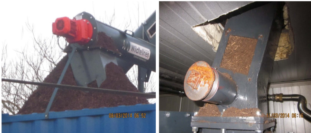
Abbildung 3.6: Verstopfungen und Materialrückstau
