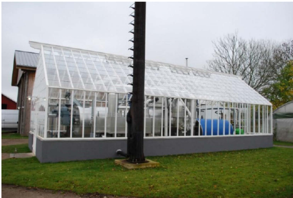
Abbildung 3.2: Gesamtansicht BlackCarbon-Anlage in einem Gewächshaus (Foto: K. Büge)
