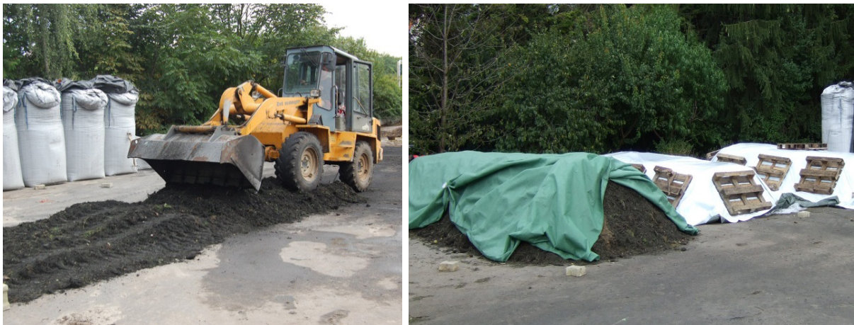
Abbildung 4.9: linkes Foto: verdichten der Fermentationsmiete; rechtes Foto: Fertige Versuchsmieten (weiß abgedeckt: Fermentationsmieten, grün abgedeckt: Kompostmieten)
