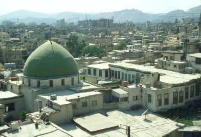
Abb. 1187: Zāwīya al-Balṭaḡīya und umgebende Wohnbauten (Weber)
