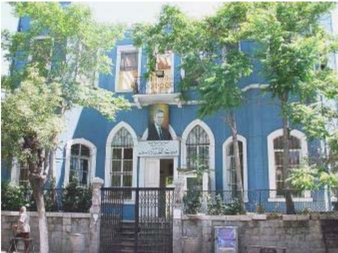
Abb. 1198: Haus Kataster XXIV-811, Straßenfassade (Weber)
