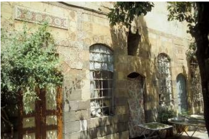
Abb. 1206: Bayt al-Ābid, Hof Nordseite (Weber)
