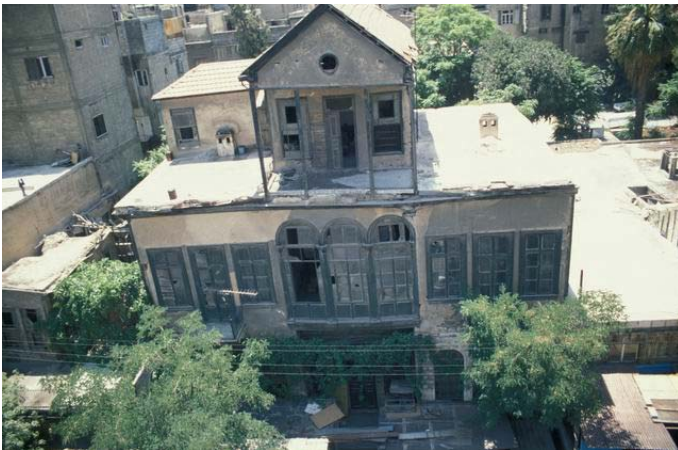
Abb. 1199: Bayt Ġabrī, Straßenfassade (Weber)
