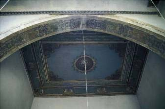
Abb. 984: Decke im Īwān (Weber)
