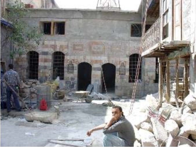
Abb. 975: Bayt al-Ġannāwī, Ostfassade (Weber)
