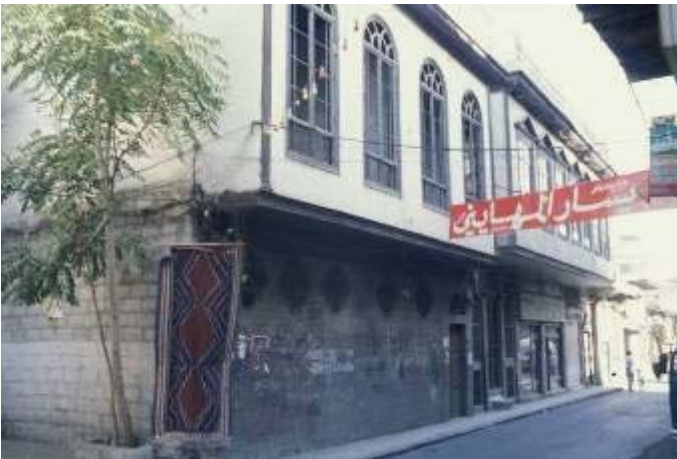
Abb. 997: Bayt ‘Abd an-Nūr, Straßenfassade (Weber)
