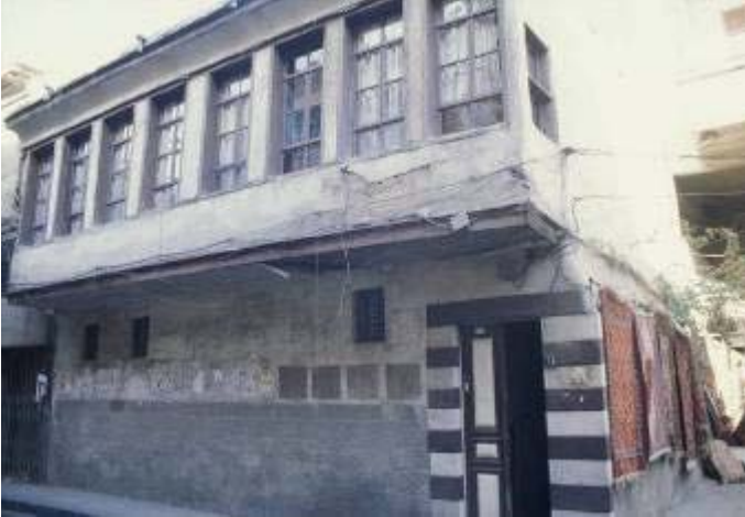
Abb. 996: Bayt az-Zarzūrī, Straßenfassade (Weber)
