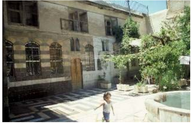
Abb. 940: Bayt al-Mallük, Hof, Westfassade (Weber)
