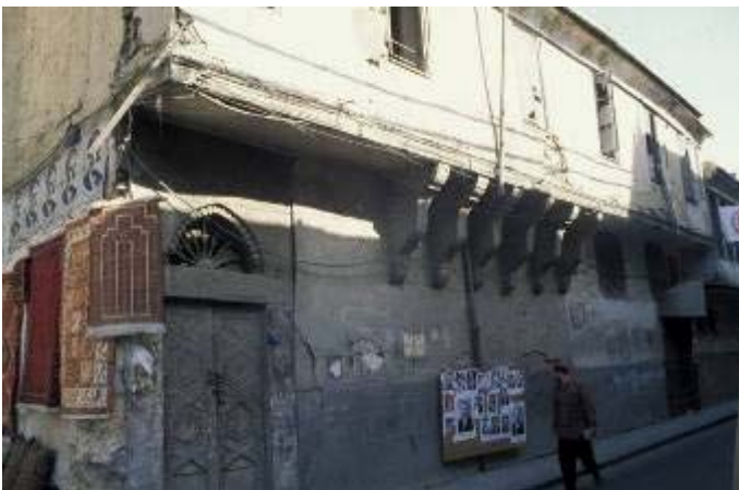
Abb. 995: Bayt an-Nimsāwī, Straßenfassade (Weber)
