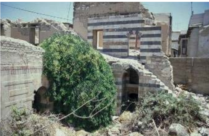
Abb. 951: Bayt aš-Šahbandar, westlicher Hof (Weber)
