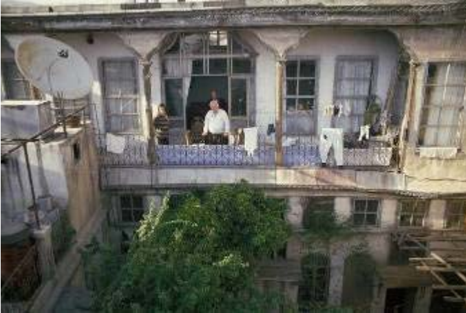
Abb. 992: Bayt 'Arbīnī, Nordfassade (Weber)
