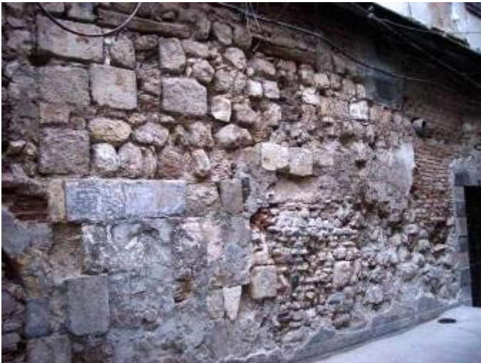
Abb. 948: Haus Katasternummer IX-50, Straßenfassade während des Umbaus (Weber)
