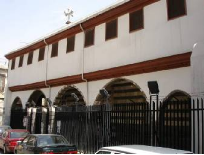
Abb. 786: Mār Yūhannā, westliche Straßenfassade (Weber)
