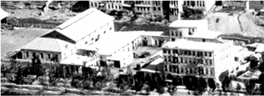
Abb. 704: Eisfabrik / (spter Kasino al-Ḥaql aṣ-Ṣaġīr (Mit freundlicher Genehmigung: IFPO)
