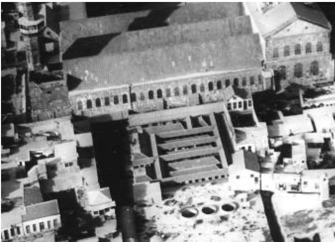
Abb. 753: Sūq aṣ-Ṣāġa, Luftaufnahme 1933 (Mit freundlicher Genehmigung: IFPO)
