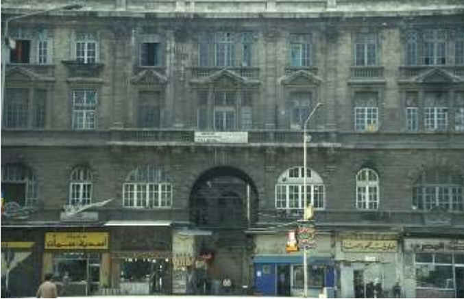
Abb. 764: Handelshaus al-ʿĀbid, Nordfassade, Hotel im 3. OG (Weber)
