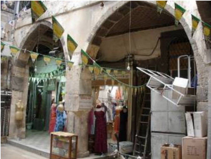
Abb. 722: Ḥān az-Zaʿfaranġīya, Hof Nordseite (Weber)
