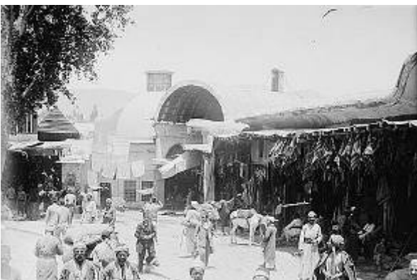
Abb. 755: Eingang Sūq as-Surūḡīya mit dem Ḥammām ar-Ra's, ca. 1890 (Library of Congress)
