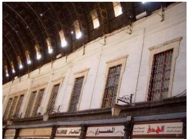
Abb. 150: Sūq al-Ḥamīdiyya, OG (Stahlträger als Sturz)
