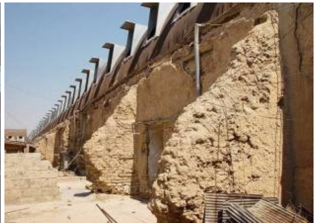
Abb. 163: Sūq Midḥat Bāšā, Blendfassade und Dachkonstruktion von außen
