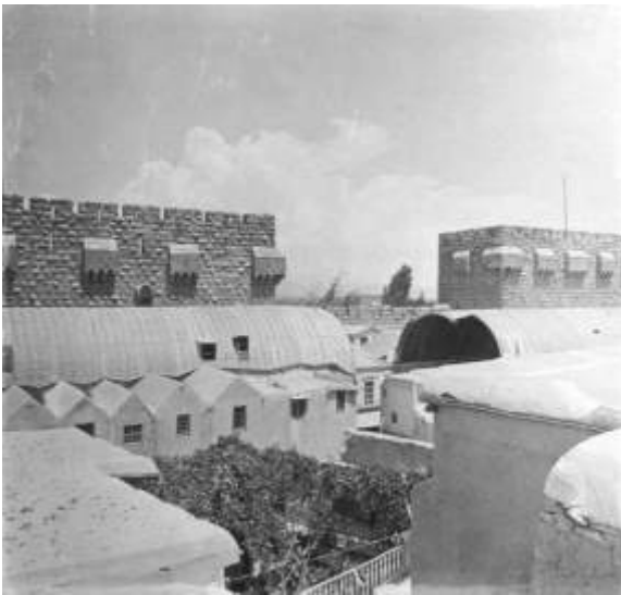
Abb. 160: Sūq al-Ḥamīdiyya, Abdeckung mit der Holztonne, ca. 1900
