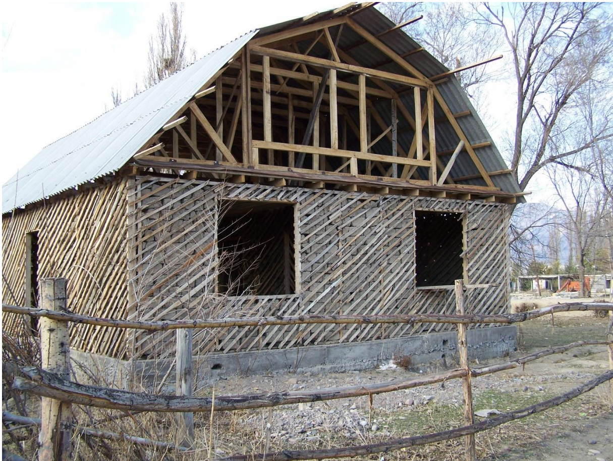
Abbildung 44: Lehmziegelbauweise mit stabilisierender Holzverstrebung bei einem Rohbau in Tasma
