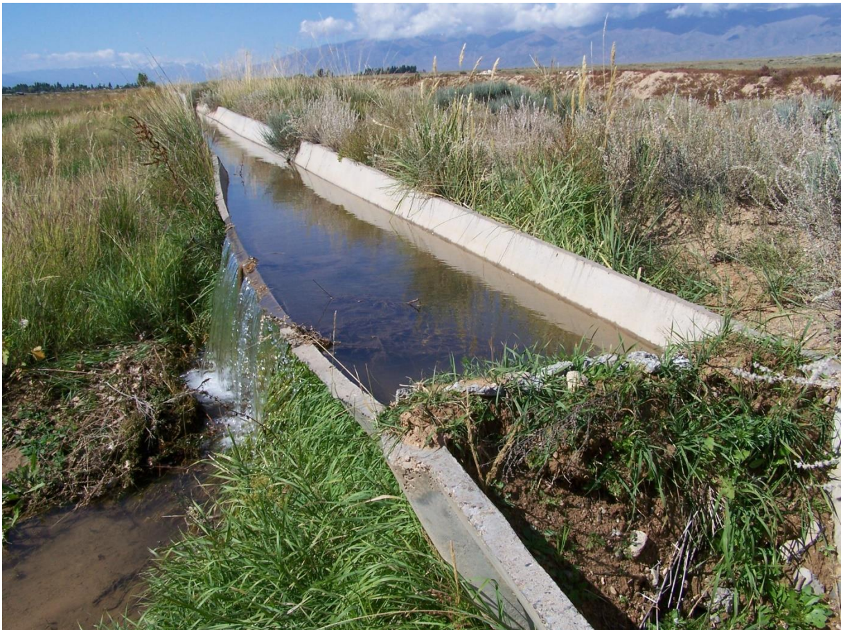
Abbildung 48: Intakter Bewässerungskanal in Toru Aigyr Das Wasser wird in den Kanälen gestaut, bis es überläuft und dann in Erdfurchen auf das Feld geleitet. Wehrklappen zum Stauen existieren nicht mehr. Foto: BW, 24.9.09
