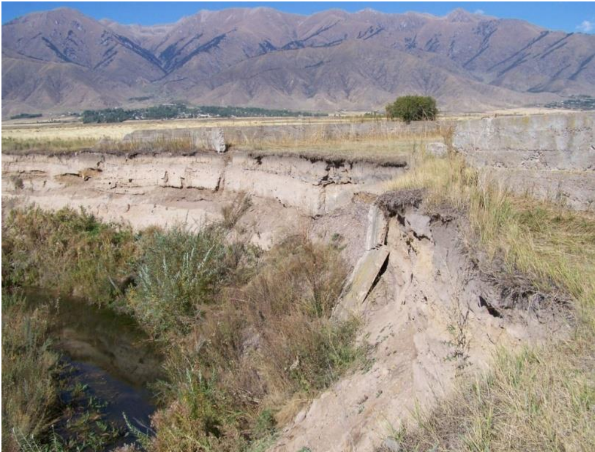
Abbildung 32: Ufererosion am Fluss Tjup in Tasma
