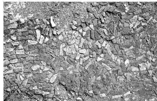
g) Haus AI.3-4: Ziegelfußboden von Raum e
