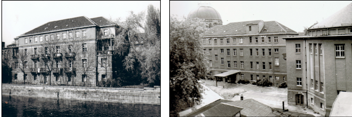
Abbildung 33: Das Ida Simon Haus (links Spreeseite, rechts „Hofseite“ mit Eingangsbereich).
