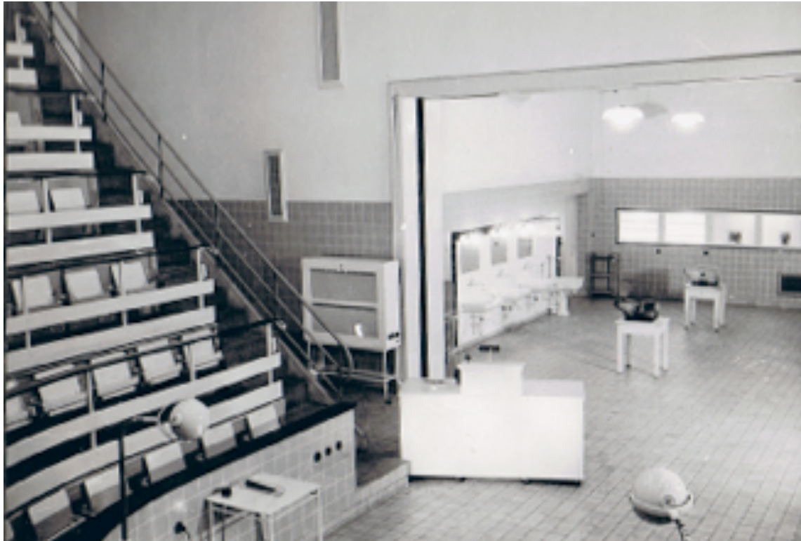
Abbildung 22: Der Hörsaal mit Trennwand und Blick in den sich anschließenden OP-Vorbereitungsraum.
