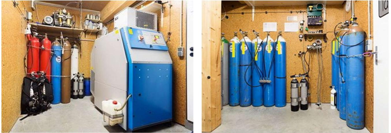
**Abb. 3: Füllraum des Ausbildungszentrums für Mischgastauchen in Geretsried; links: Atemluftkompressor mit Luftdepot; rechts: Mischanlage mit O<sub>2</sub>- und He-Speicherflaschen (Quelle: [www.mischgastauchen.de](http://www.mischgastauchen.de))**
