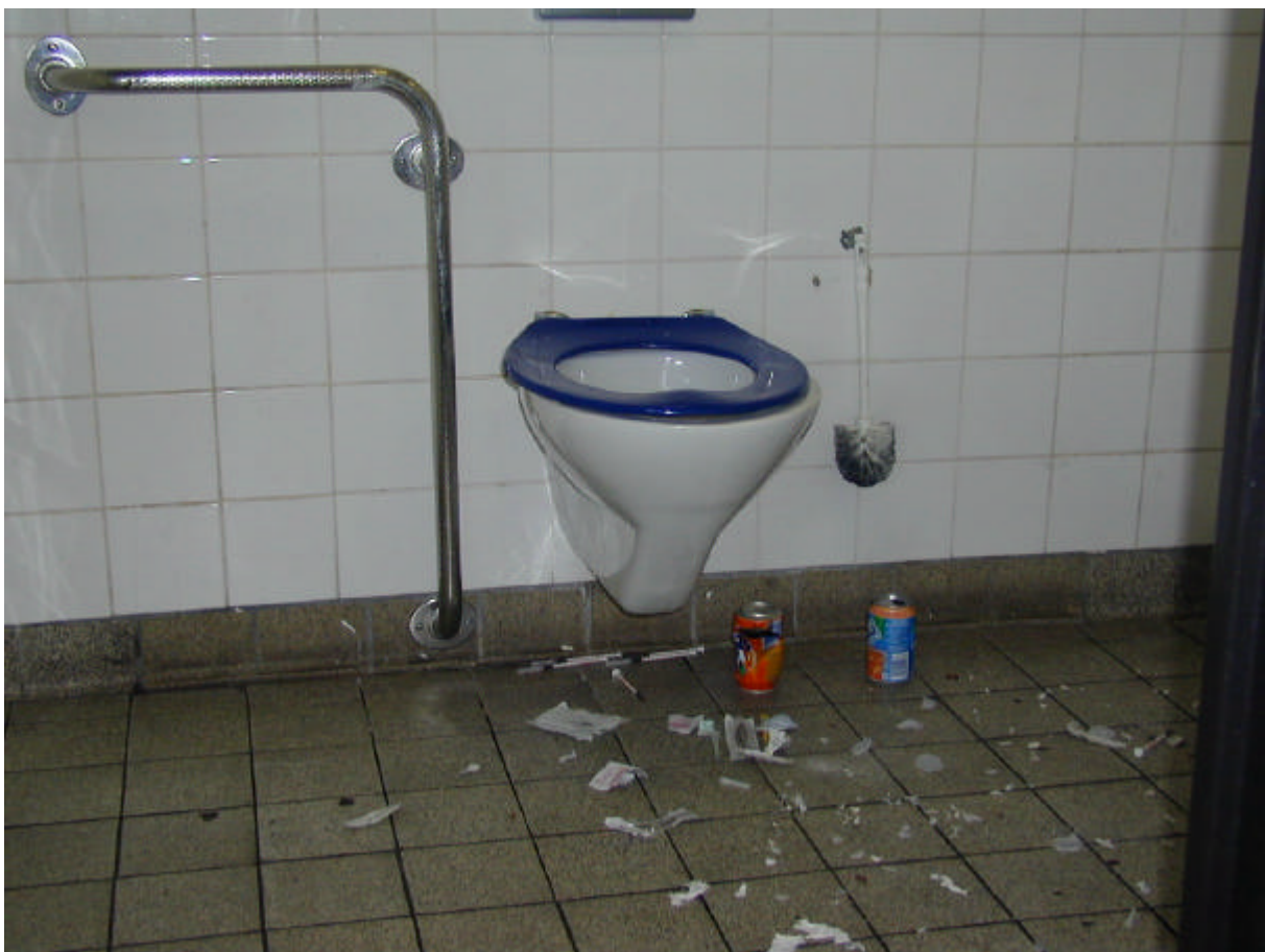
Abb. 1: gelegentlicher Zustand öffentlicher Toiletten vor den Reinigungsmaßnahmen
